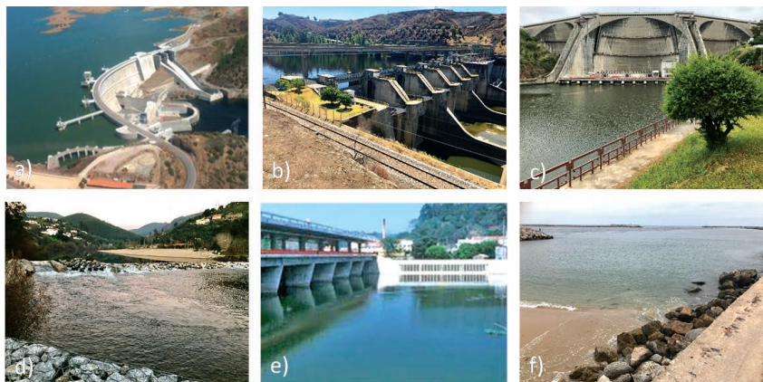
Figura 2.3. Exemplos de obras hidráulicas construídas nos principais rios em Portugal: a) barragem do Alqueva, no Guadiana, criando o maior lago artificial da Europa, com uma capacidade de pleno armazenamento de 4150 hm 3 e uma área inundável de 250 km 2 ; b) barragem do Fratel, no Tejo, após o grande incêndio florestal em Pedrogão Grande, em 2017; c) barragem da Aguieira, no Mondego, essencial ao cumprimento dos objetivos do projeto do Mondego, de fins múltiplos; d) açude a jusante da praia fluvial de Torres de Mondego, no rio Mondego; e) açude-ponte de Coimbra, no Mondego, e vista da tomada de água no canal condutor geral, para rega do Baixo Mondego; f) entrada do porto da Figueira da Foz, na foz do Mondego. Fotografias: a, http://www.geografia7.com/os-rios-em-portugal.html ; b–f, João L.M.P. de Lima.
