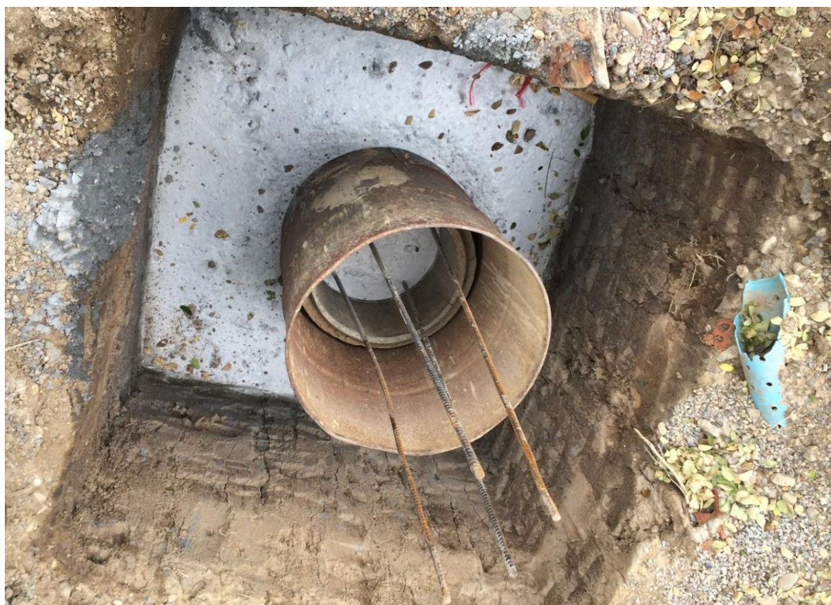
Figura 118 Cimentaciones utilizadas en Bamboo Sports Hall
