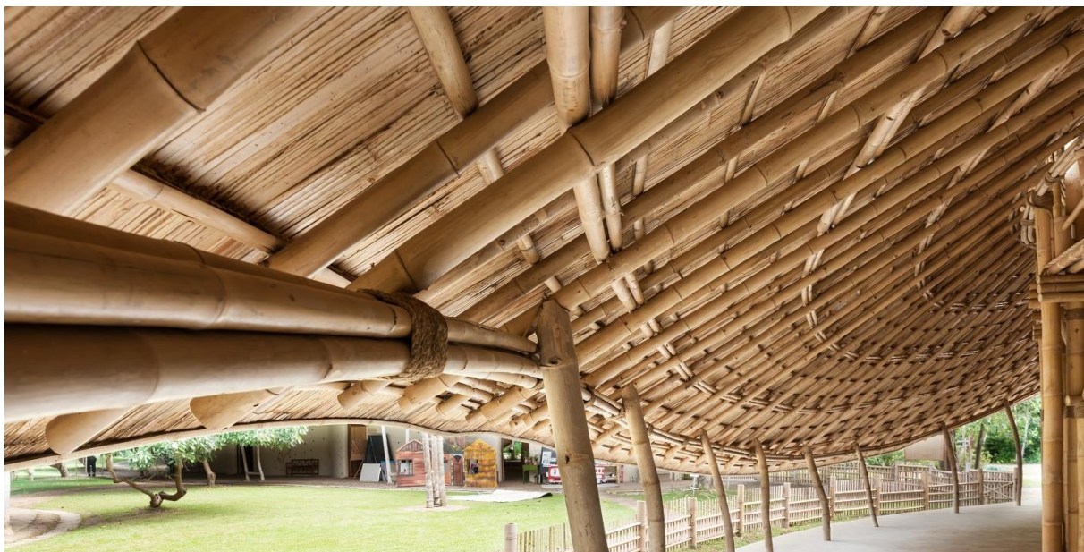
Figura 124 Esterilla de bambú utilizada en la cobertura de Bamboo Sports Hall
