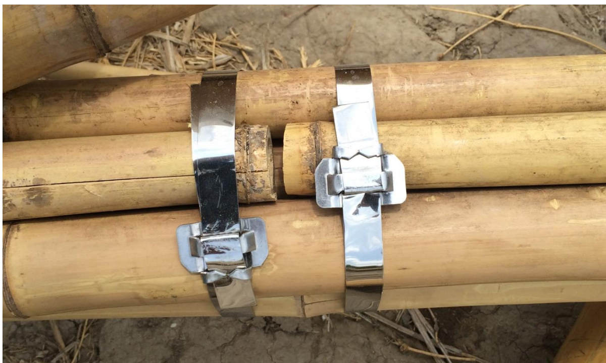
Figura 129 Unión longitudinal del bambú en Bamboo Sports Hall
