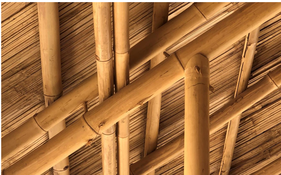
Figura 116 Uso de pasadores de bambú en Bamboo Sports Hall
