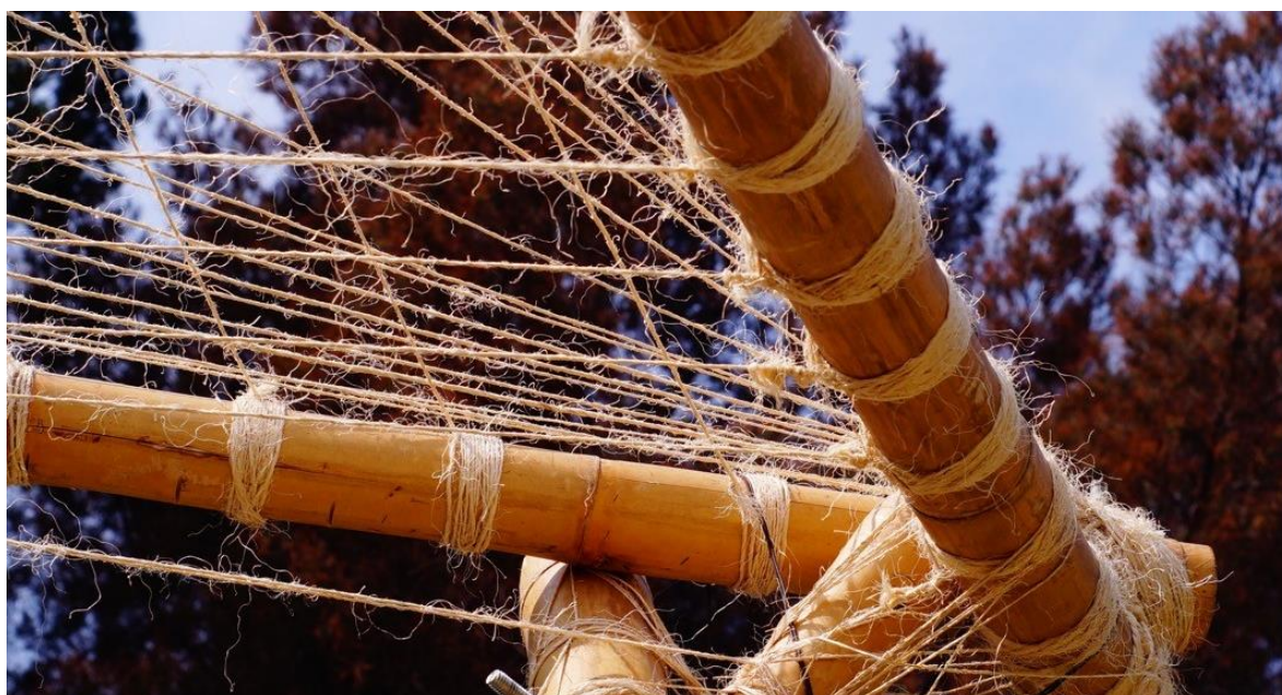
Figura 59 Aplicación de amarres en un pabellón de bambú
