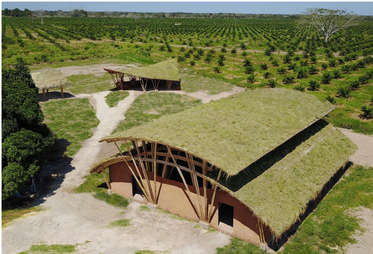
Figura 112 Dormitorios de La Ceiba vinculado a su entorno
