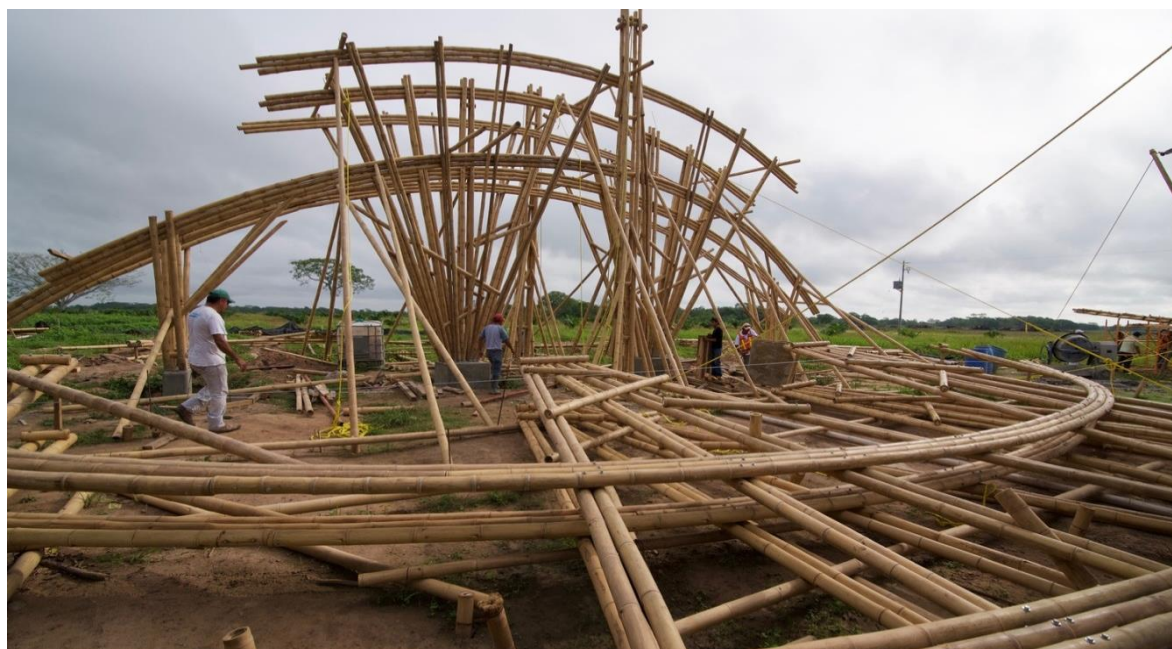
Figura 135 Proceso constructivo de los dormitorios de La Ceiba
