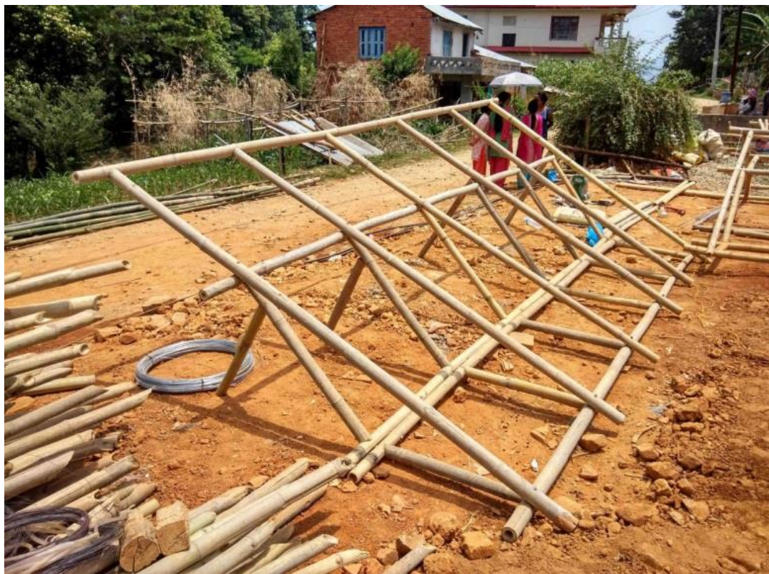
Figura 13 Estructura cubierta realizada en bambú en Nepal
