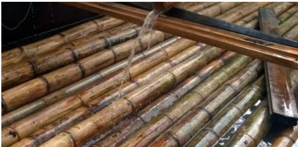
Figura 39 Preservación de Bambú
