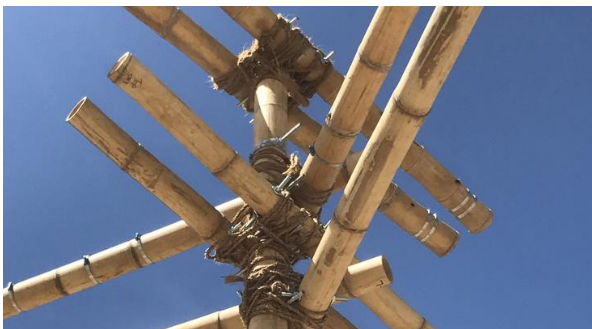
Figura 60 Unión con la combinación de cuerdas naturales y espárragos metálicos
