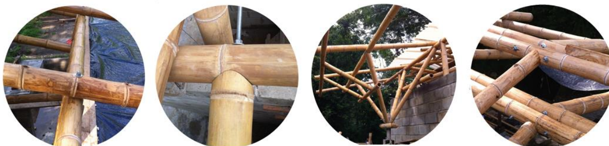
Figura 69 Aplicación de las diferentes uniones en estructuras de bambú
