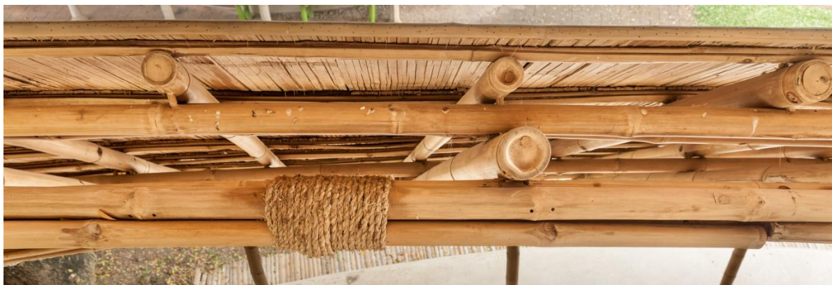
Figura 140 Sellantes de bambú utilizados en los extremos de los tallos de Bamboo Sports Hall
