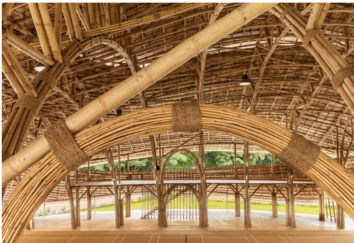
Figura 101 Detalle elementos de Bambú que conforman Bamboo Sports Hall
