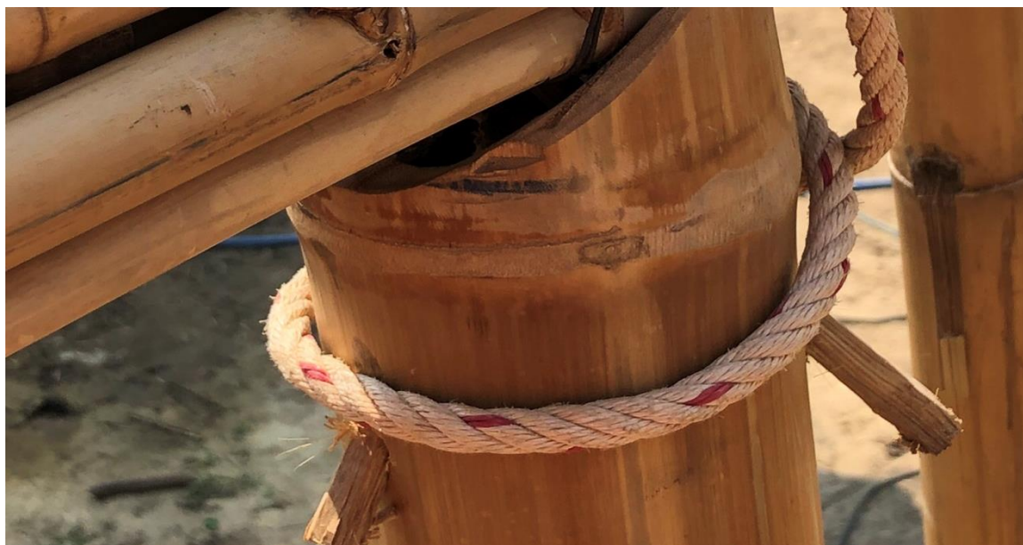
Figura 81 Uso de los pasadores de bambú en la estructura
