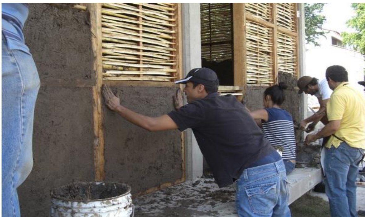
Figura 18 Proceso de construcción del Bahareque
