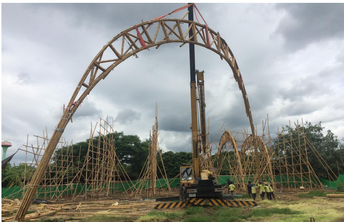
Figura 134 Proceso Constructivo Bamboo Sports Hall
