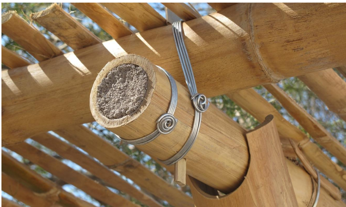
Figura 17 Uso de cemento en las uniones del bambú
