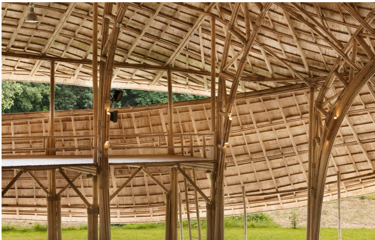
Figura 102 Elementos estructurales de bambú en el proyecto Bamboo Sports Hall
