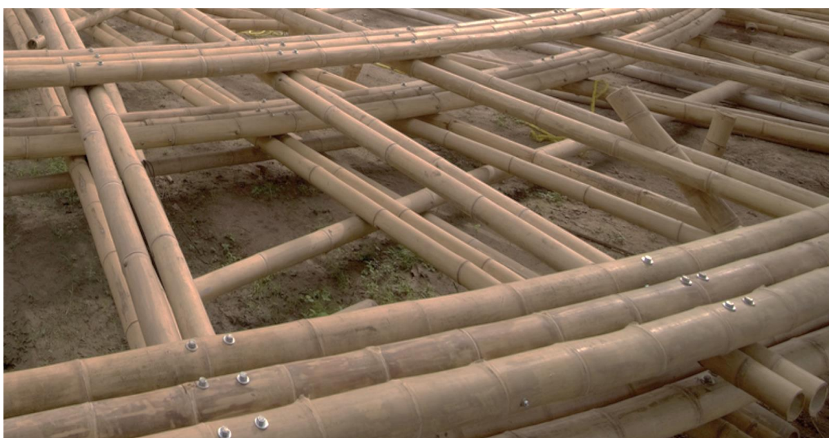
Figura 117 Uso de espárragos metálicos para la unión de las piezas de bambú
