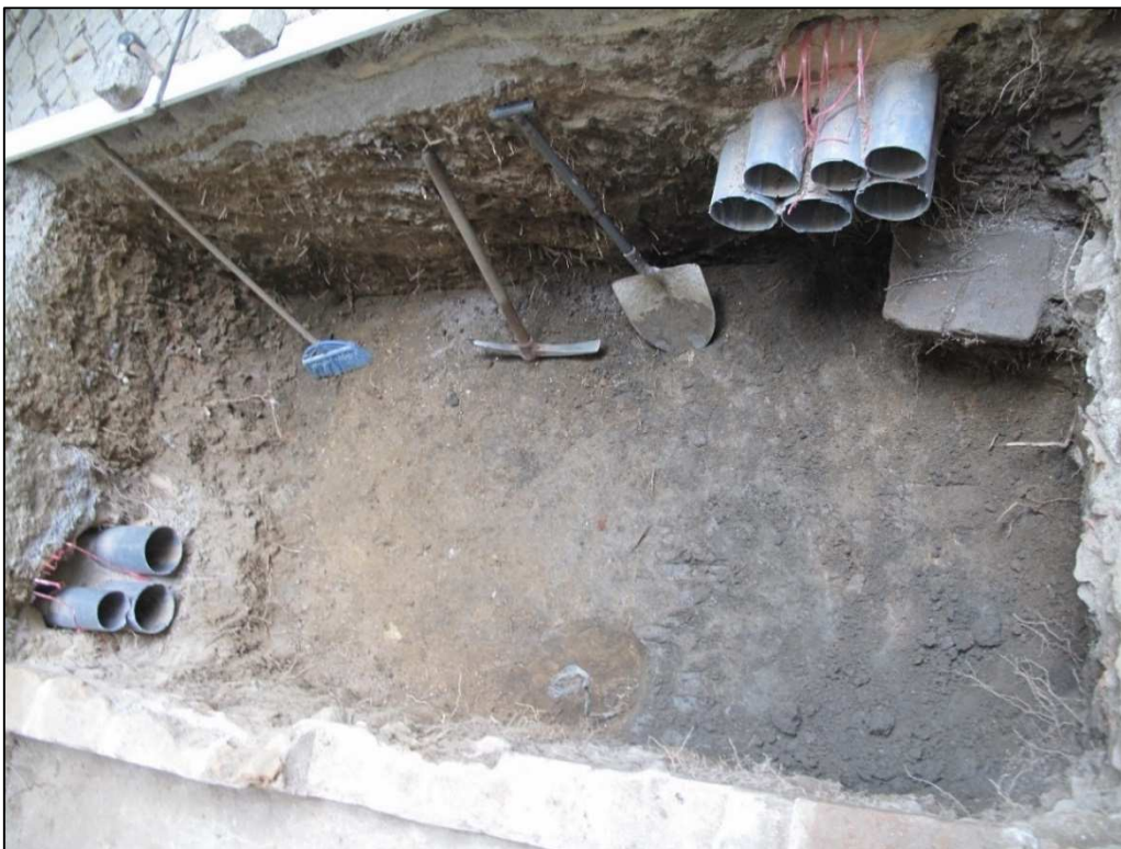
Figura 24. Aspeto final do poço, com visualização das infraestruturas anteriores, cortadas (©Leonor Rocha).
