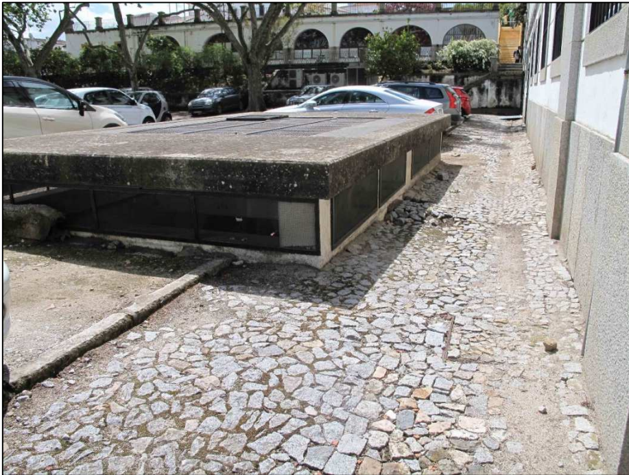
Figura 3. Infraestruturas de climatização do CES (©Leonor Rocha).
