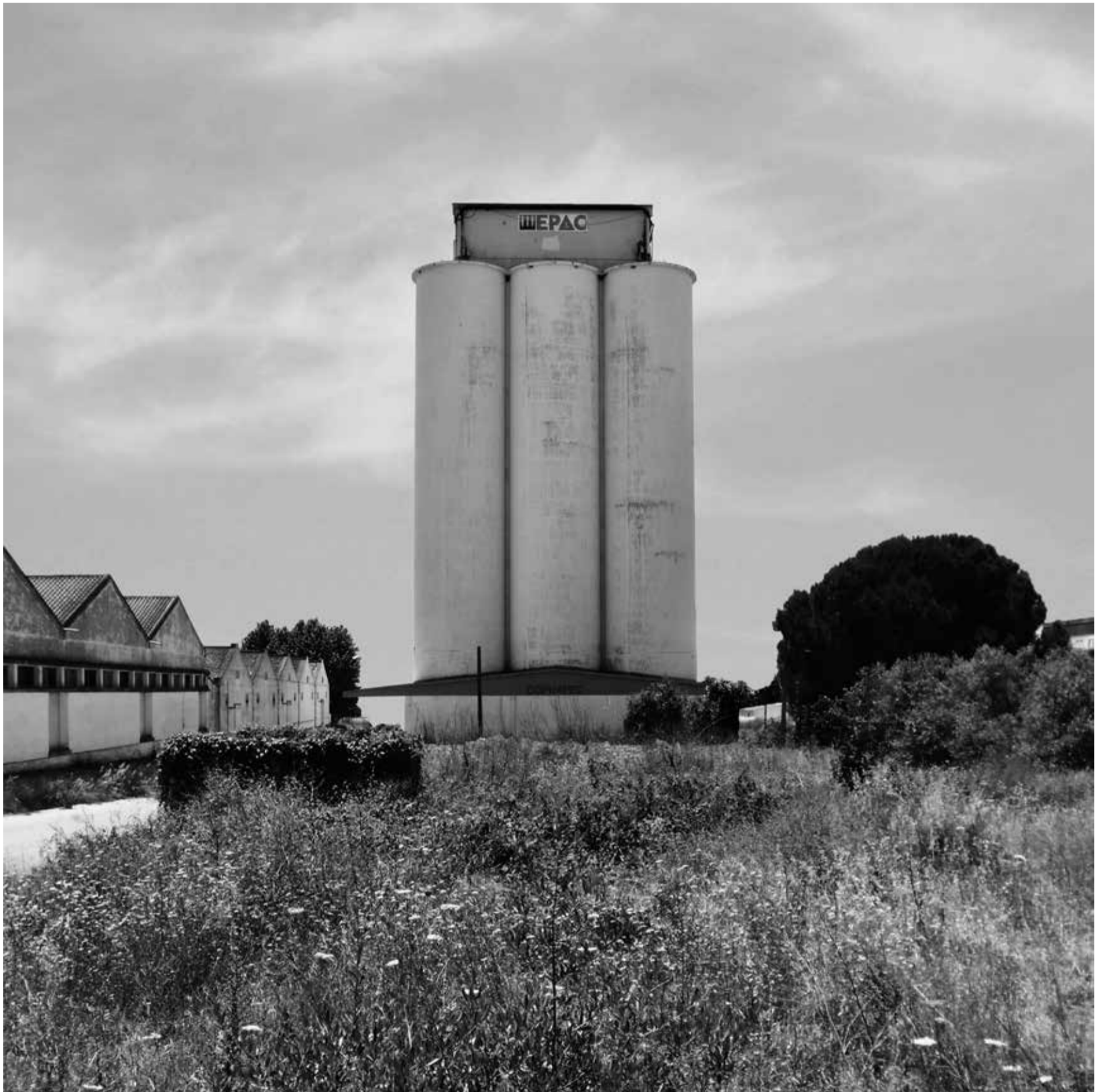
fig.270 Silo da EPAC de Évora, fotografia do autor, 2018.
