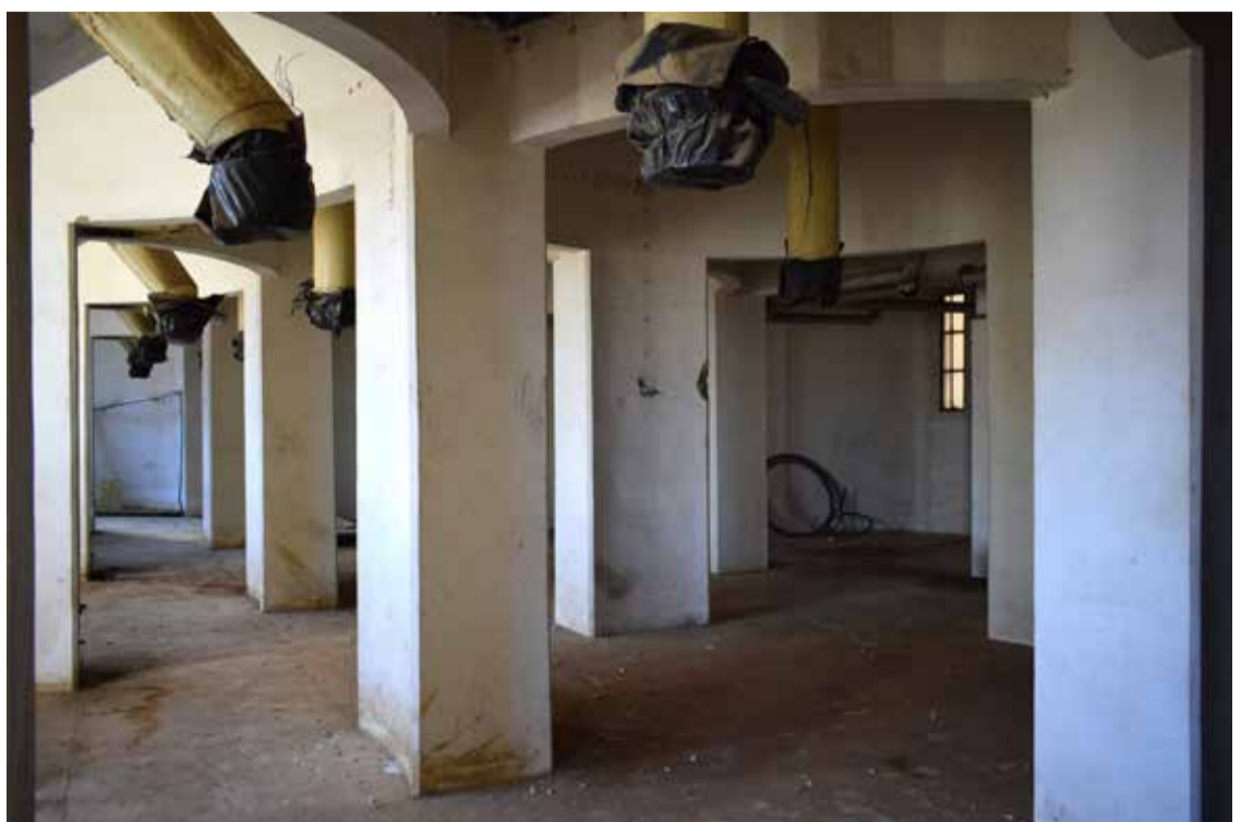
fig. 99 Galeria inferior de distribuição do cereal, fotografia do autor, 2018.
