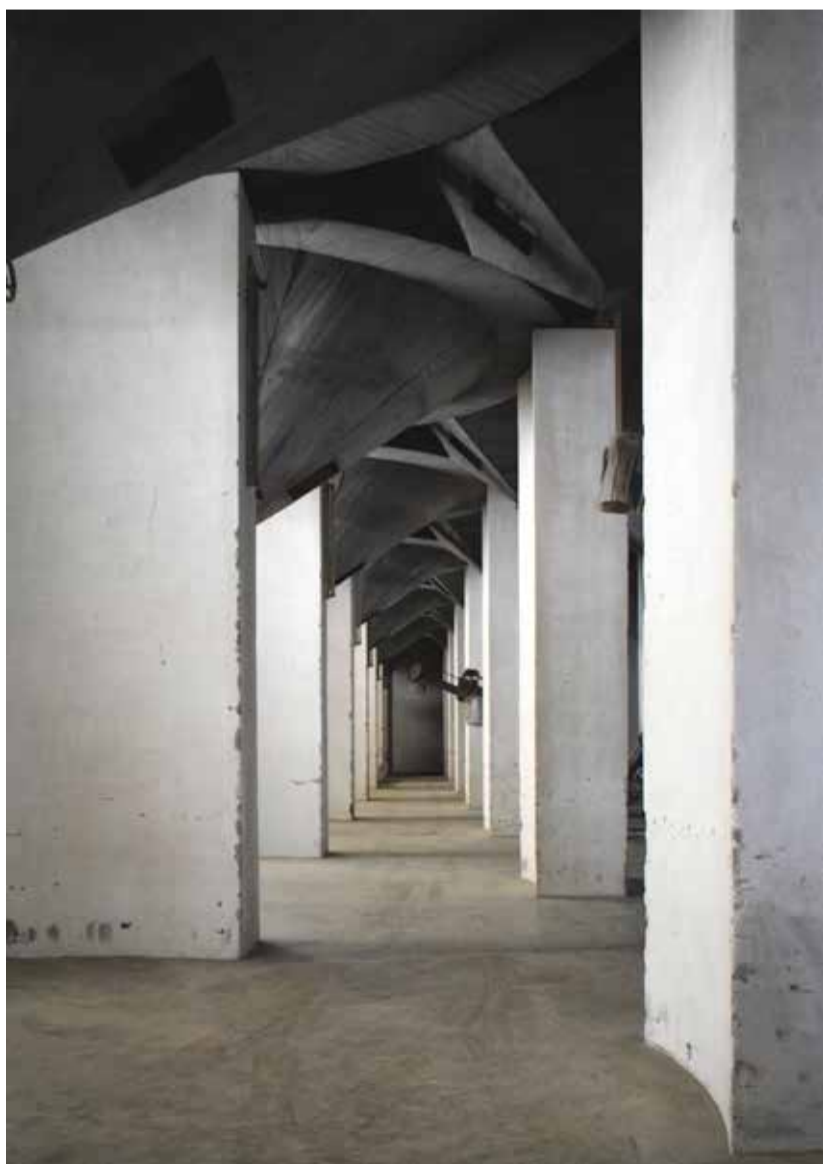
fig.221 Galeria inferior de distribuição do cereal, fotografia do autor, 2017.
