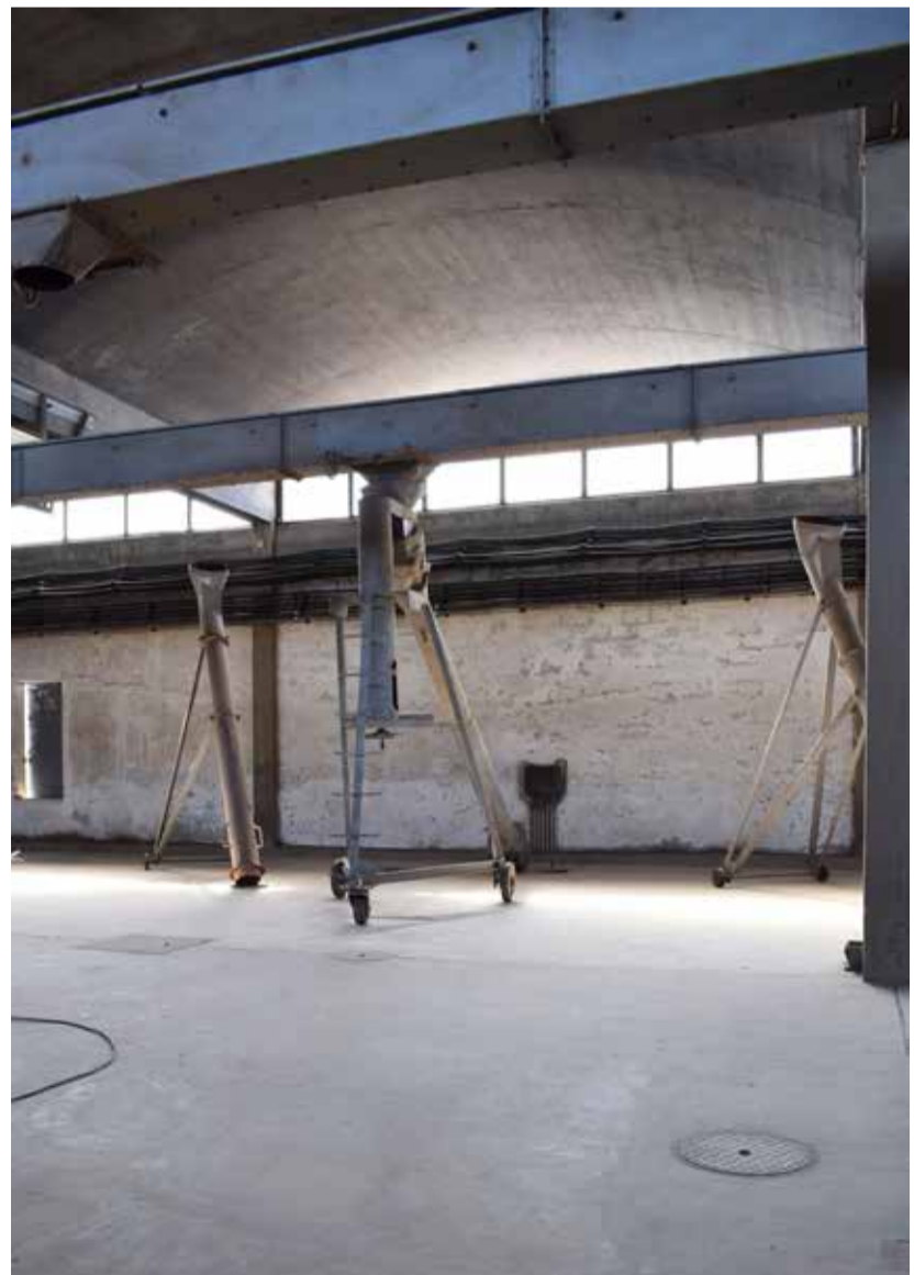
fig.226 Galeria superior de distribuição, tubo de queda do cereal até ao silo, fotografia do autor, 2017.
