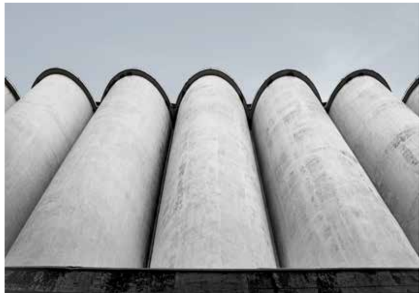
fig.228 Silos da EPAC de Évora, fotografia do autor, 2017.
