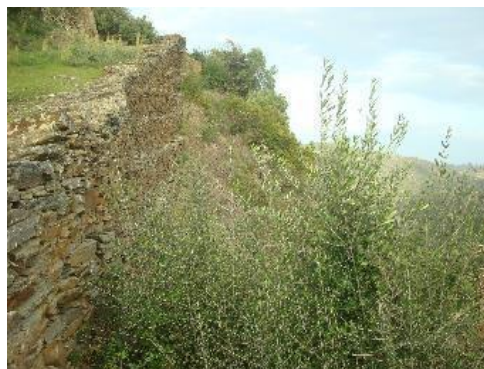
Figura 36 – Muro de suporte
