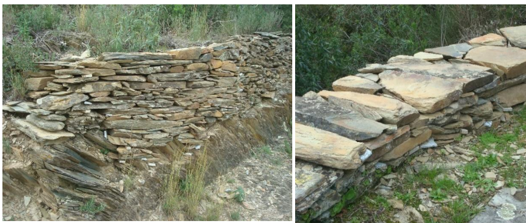
Figura 41 e 42–Pormenores de reconstrução dos muros de alvenaria de pedra.
