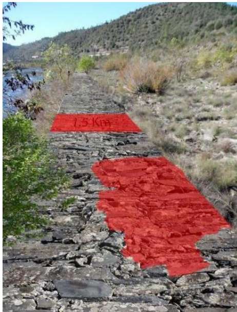
Reconstrução de troços de muro
