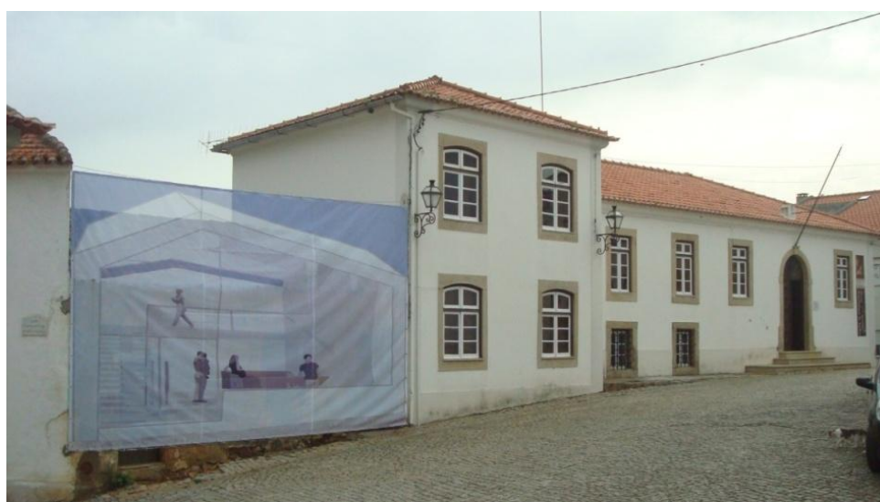
Figura 3 - CIARVT: Instalação efetuada pela autarquia em 2012.
