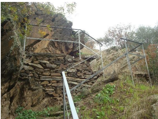
Figura 59– Acesso e estrutura de proteção
