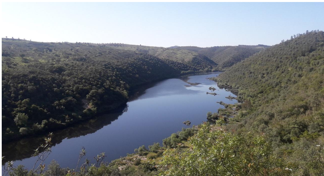
Figura 71 – Vista jusante do núcleo do Cachão do Algarve.
