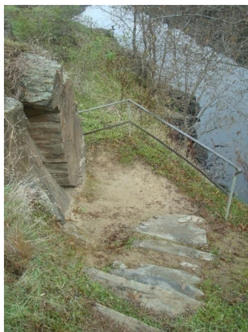
Figura 60 - Acesso e estrutura de proteção
