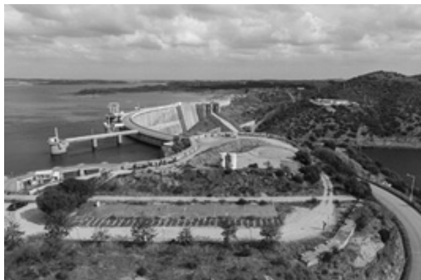
Figura 7 - Vista do local de intervenção
