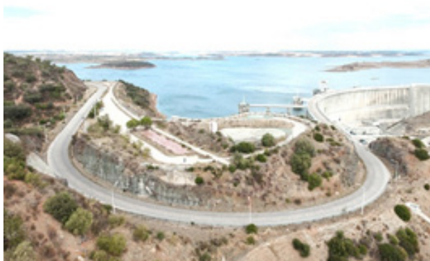
Figura 5 - Vista do local de intervenção
