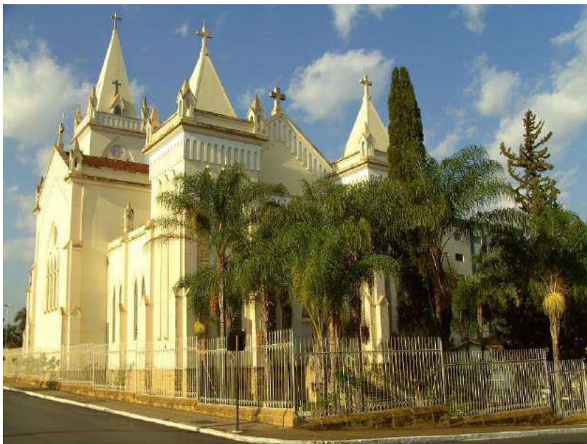
Figura 5 – Fachada antes da retirada de palmeiras.
