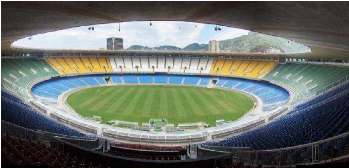
Figura 3 – Interior do estádio antes da revitalização.
