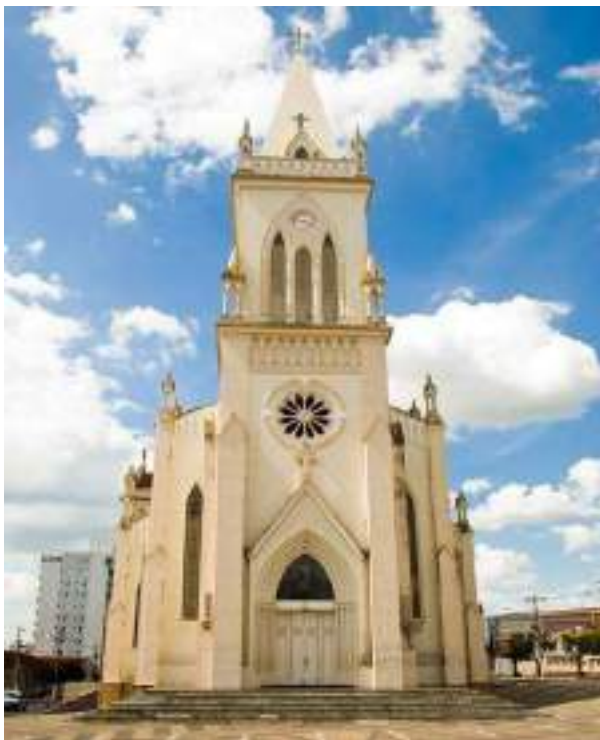
Figura 9 – Fachada principal da catedral antes da revitalização.
