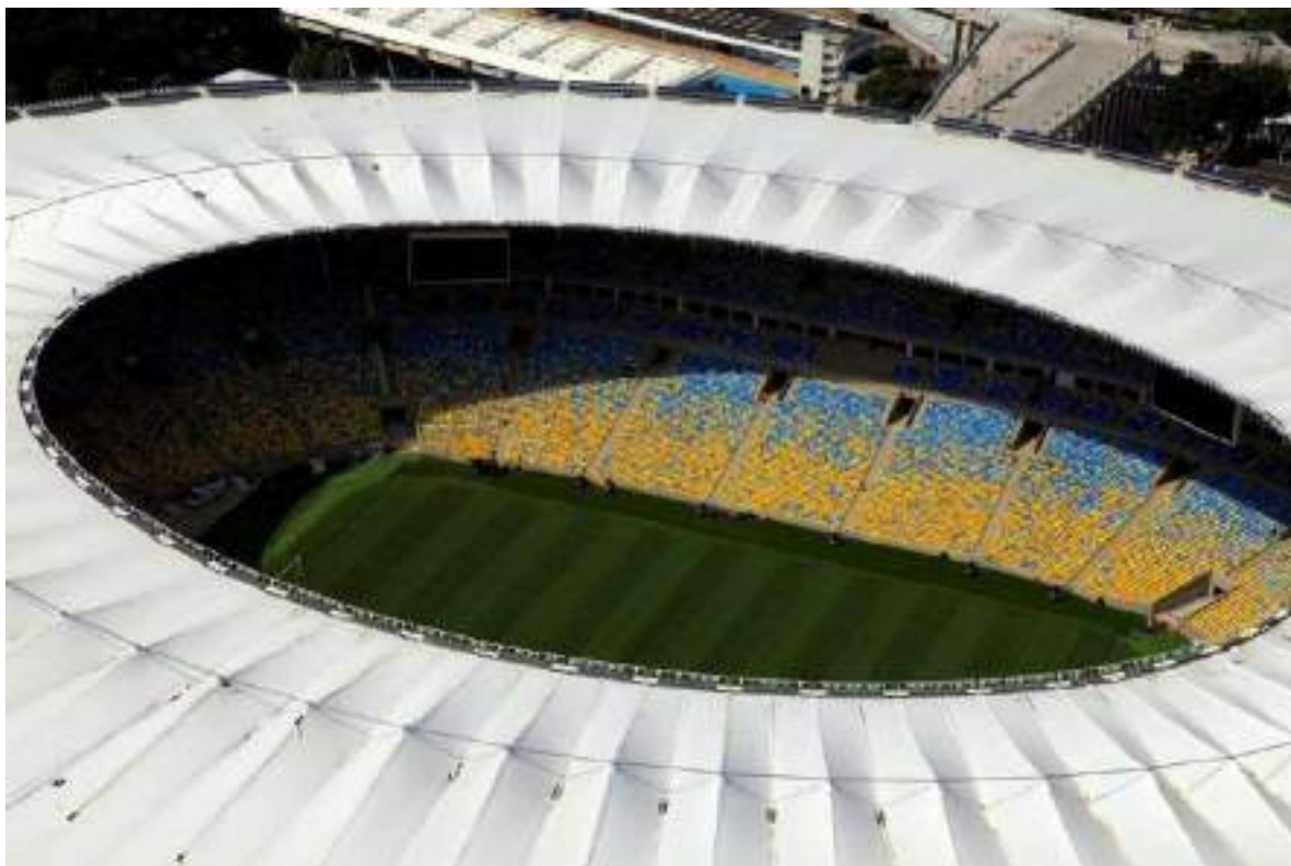
Figura 2 – Cobertura do estádio após a revitalização.
