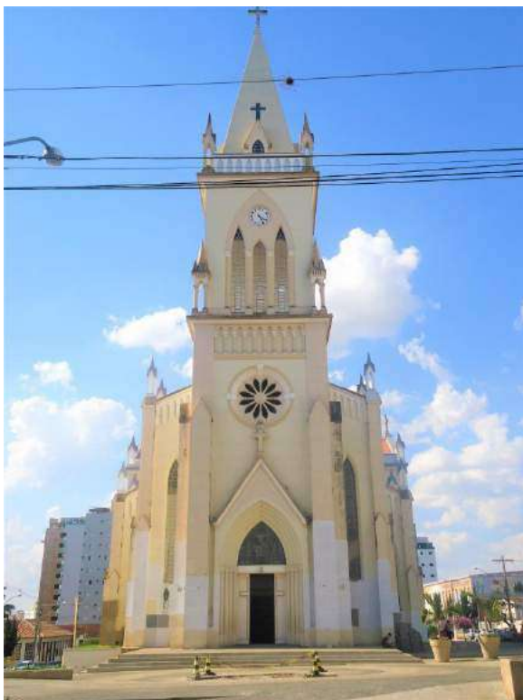
Figura 10 – Fachada principal da catedral durante a revitalização.
