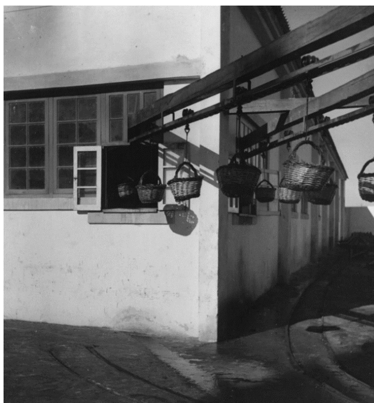
Cais de transporte de peixe para o interior da fábrica CDAH Portimão – MP – D29 – 18/CDAH Portimão – MP – D29 – 19
