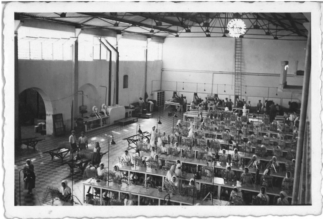
Sala de enlatamento da fábrica Feu Hermanos CDAH Portimão - MP-D2-5B-D
