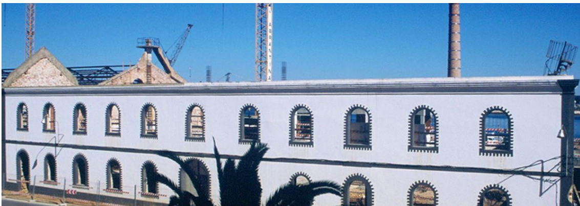
Fachada poente em construção www.museudeportimao.pt
