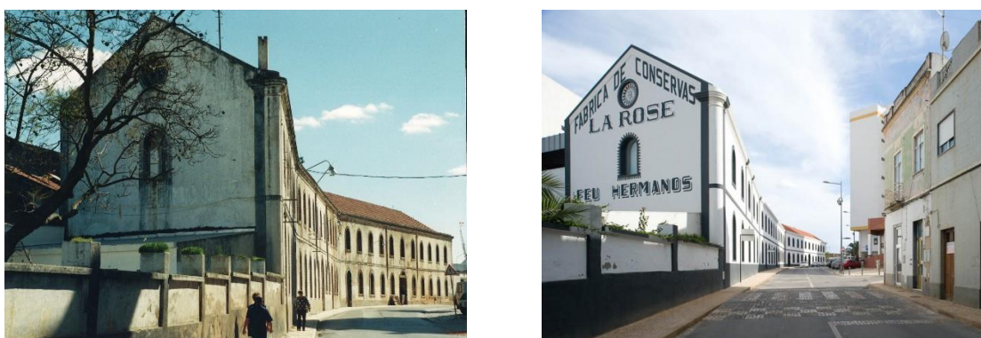
Figura 2 e 3 - Edifício da antiga fábrica Feu, antes e depois da reabilitação
