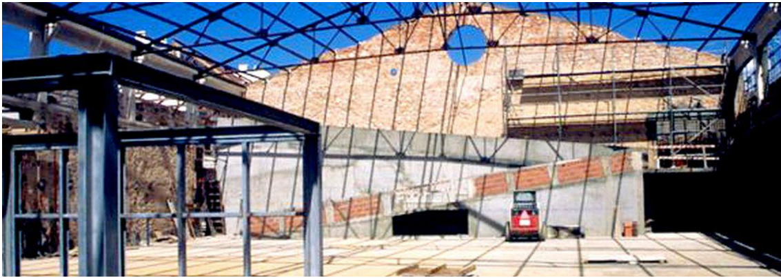
Nave da exposição permanente em construção www.museudeportimao.pt
