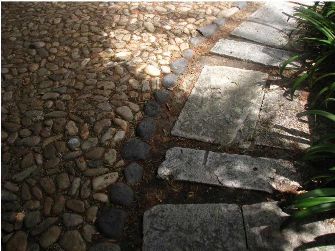
Figura 64 – Detalhe do pavimento, Quinta da Praia das Fontes (Ana Sofia Silva, 2018)
