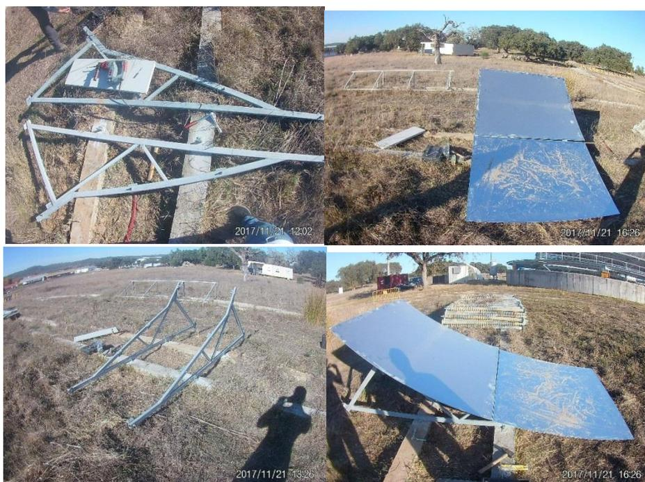
Figura 22 - Em cima à esq. estrutura metálica; Em baixo à esq. estrutura metálica montada; Em cima à dir. e em baixo à dir. estrutura metálica montada com espelhos concentradores.
