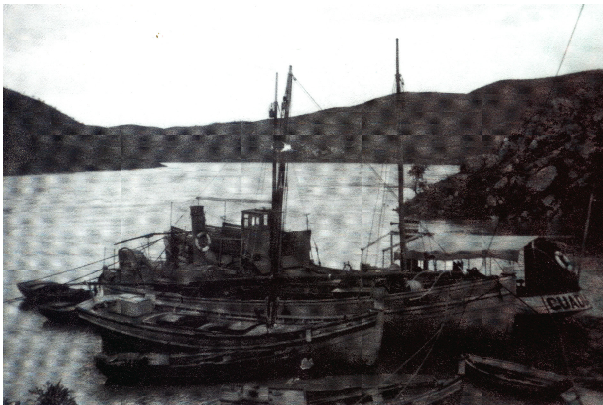
Fig. 35: Porto para marítimos no Guadiana, cerca de 1950
