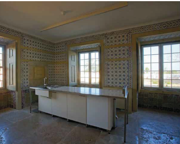
Figs. 14 e 15 – Casa nobre: sanitários e cozinha; actualização para o uso contemporâneo mantendo a visibilidade das pinturas murais e no tecto, e do padrão pombalino de estrelinha, em azul cobalto sobre fundo branco. Fonte: Filipa Bernardo (2018).
