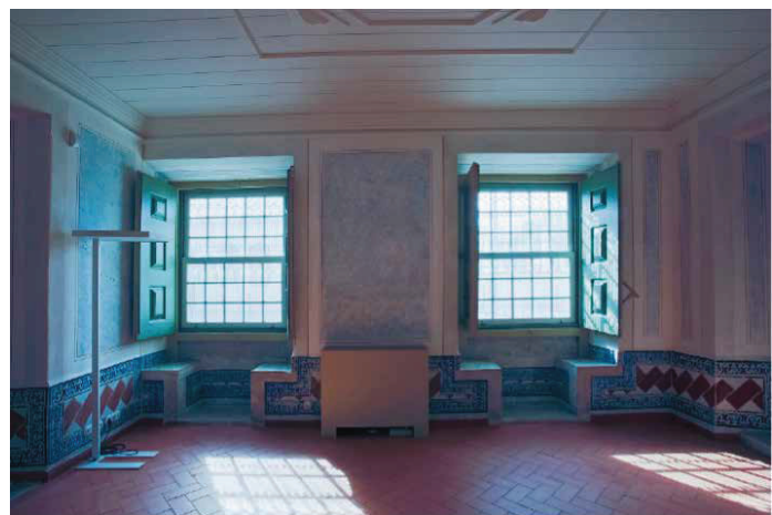
Figs. 12 e 13 – Reinfraestruturação: iluminação, energia, aquecimento e segurança contra incêndio coexistem com programas decorativos em pavimentos, paredes e tectos. Fonte: Filipa Bernardo (2018).
