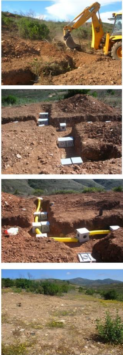
Figura 2 – construção de um abrigo de tubos (Fot: Cláudia Encarnação, 2007)
