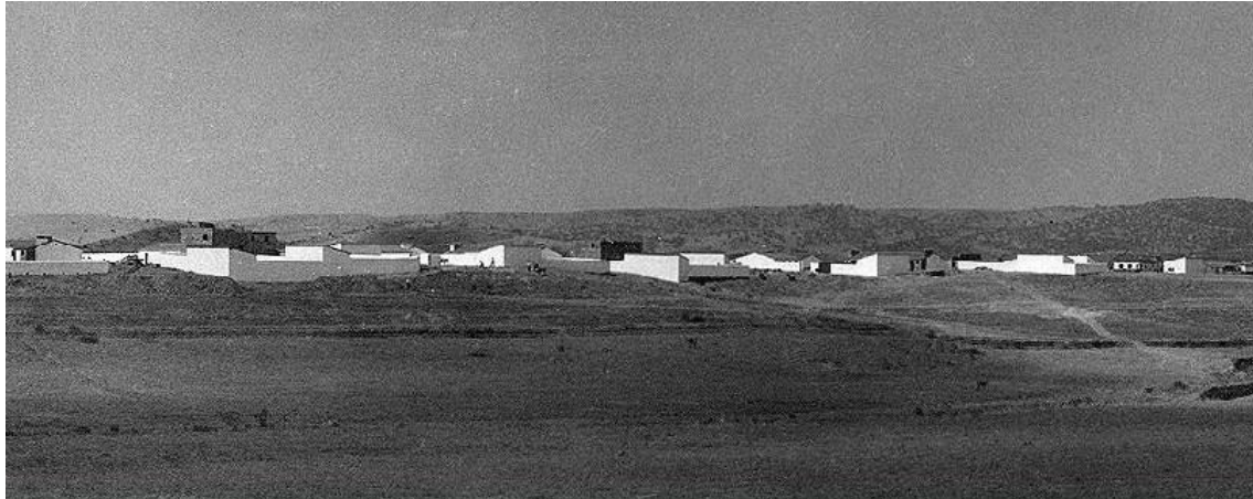
Figura 22: Fotografia de La Bazana com algumas habitações em construção.1956. Fonte: Rando (2015).
