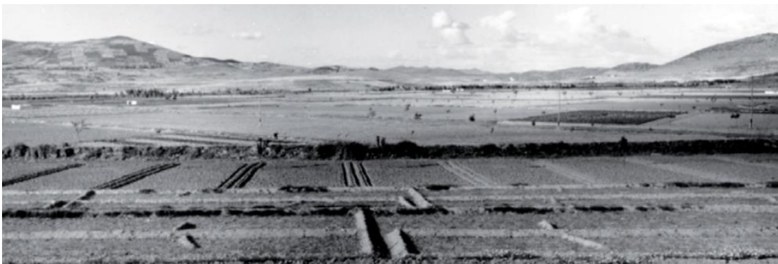
Figura 4: Construção dos canais de água (acequias) da zona de rega do Rio Ardila. Fonte: Rando (2015)
