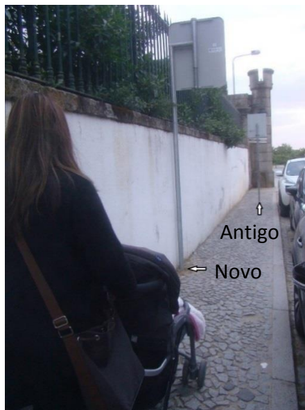
Figura 85 - Postes de sinalização, novo e antigo modo de assentamento
