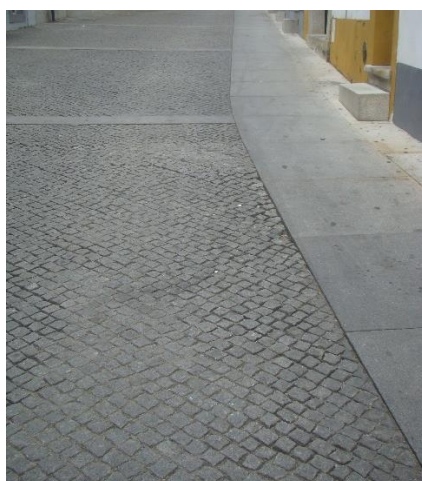
Figura 51 - Pavimentação com as lajes e cubos de granito utilizados na intervenção ÉvoraCom
