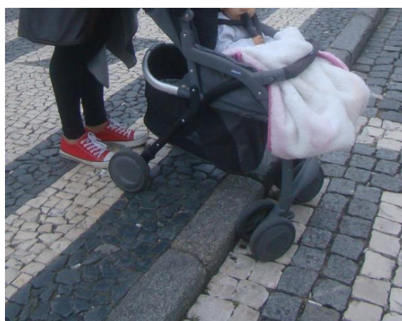
Figura 78 - Faixa de pedestre sem guia rebaixada (DL 163/2006)
