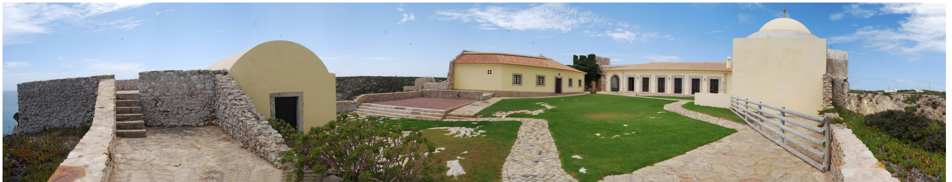
Fig. 76 - Vista do interior do forte
