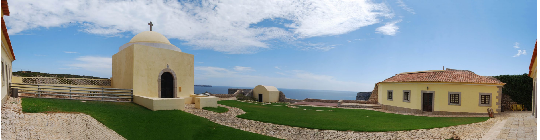
Fig. 75 - Vista do interior do forte
