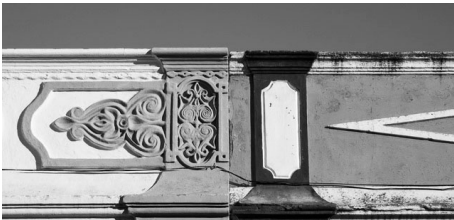
Fig. 10 - Detalhe de platibandas da Luz de Tavira.
