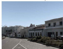
05.10.04 | As construções adjacentes à Ermida de S. João Fotografia da autora
