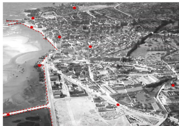
05.02 | Relação Ribeirinha da Cidade de Lagos com o primeiro aterro Fotocópia Municipal de Lagos, Colecção Franco, 1951
