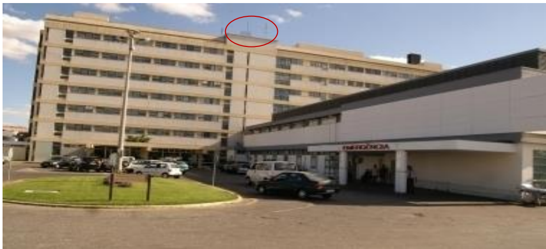
Figura 0.4. Hospital José Joaquim Fernandes em Beja (ULSBA), local onde foi colocado o coletor polínico. Figura adaptada de Google (2015).
