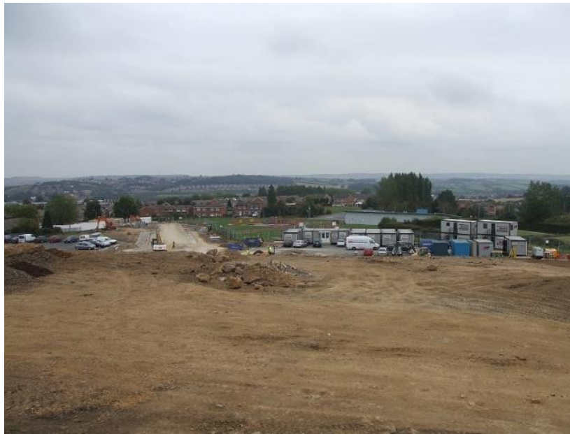
Fig. 6 – Fotografia da obra e do envolvente. Fotografia: Aedas
