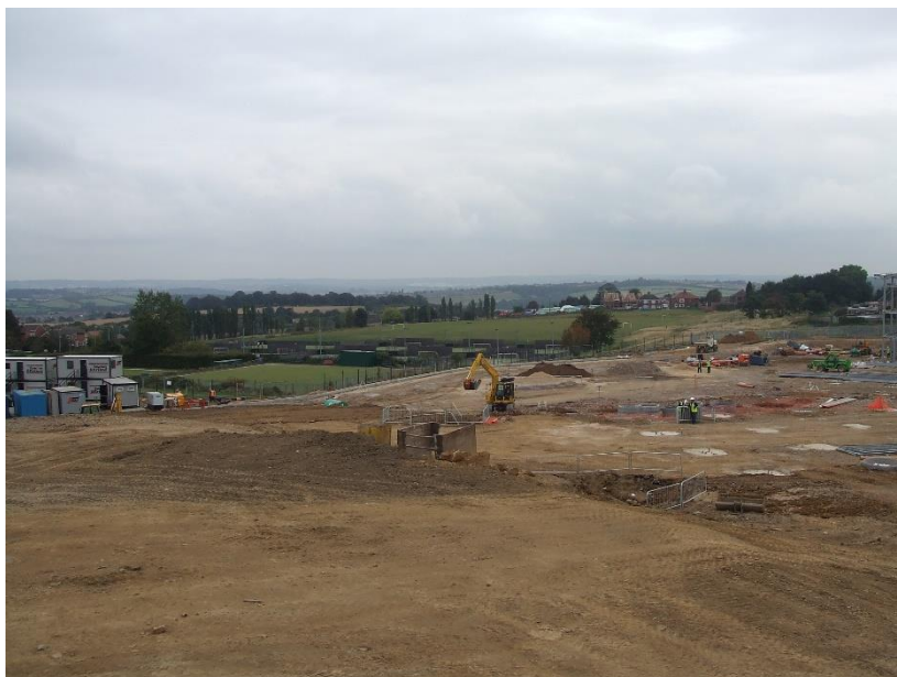
Fig. 7 – Fotografia da obra e do envolvente. Fotografia: Aedas
