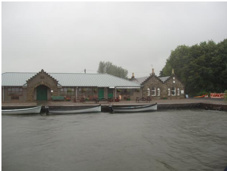
Fig. 23 – A Marina e casa de barcos existente
