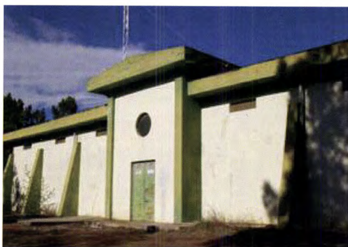
Figura 4.59 – Reservatório de água
