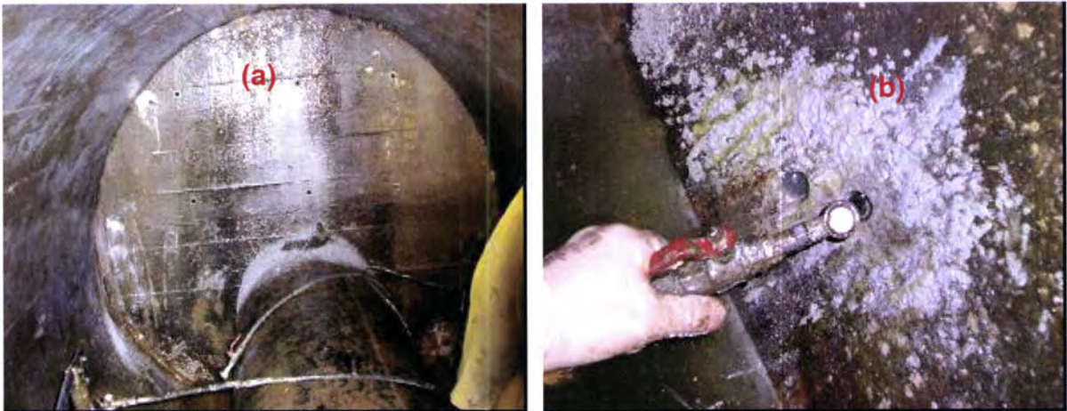
Figura 4.52 (a), (b) – Aplicação do prepolímero sintetizado em juntas e fissuras
