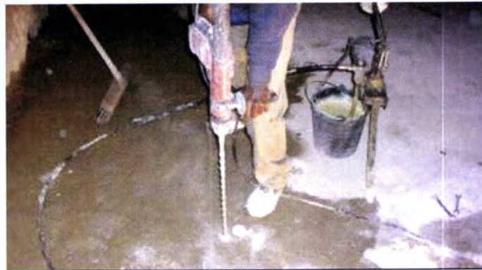
Figura 4.56 – Perfuração do buraco de injeção
