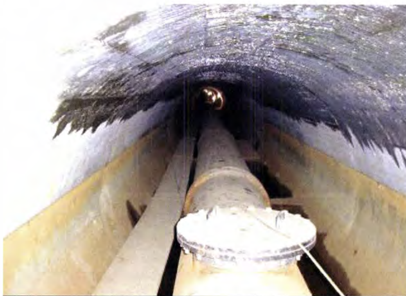
Figura 4.51 – Túnel de descarga
