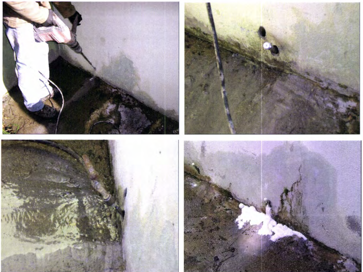
Figura 4.61– Aplicação do prepolímero sintetizado em vedação de juntas
