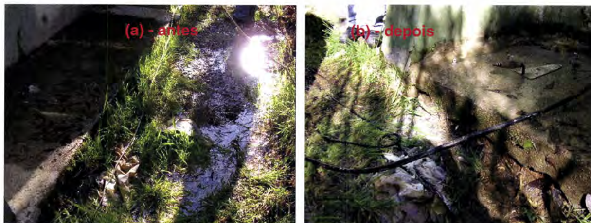
Figura 4.62 (a), (b) – Antes e depois da aplicação do prepolímero no reservatório de água
