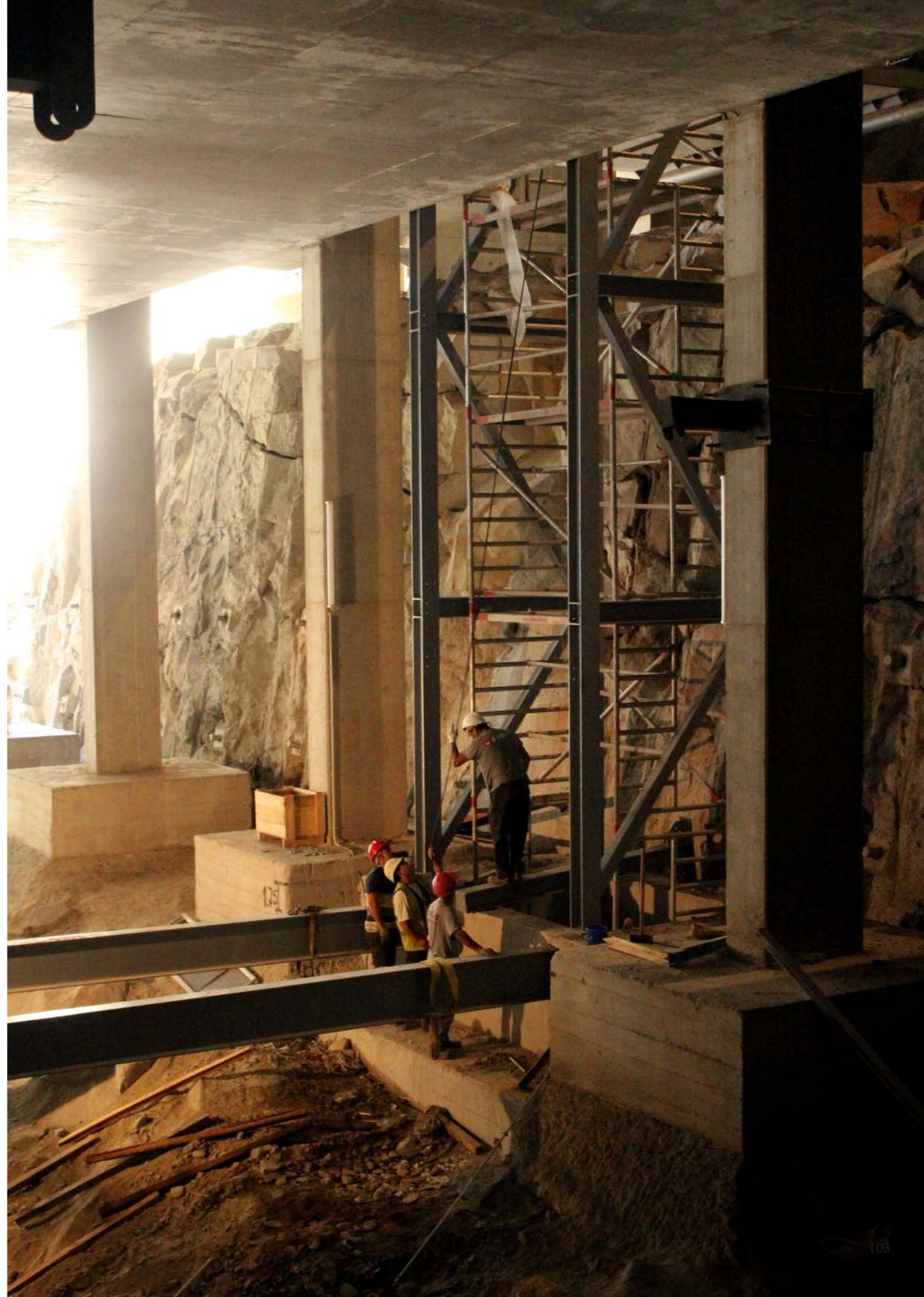
pg. 103 | imagem dos alicerces firmados na rocha (bancada poente), preparativos para instalação de um novo elevador. Fonte: autor.
