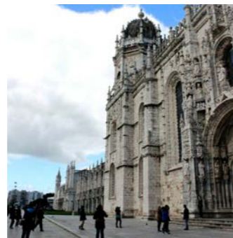
Mosteiro dos Jerónimos em Lisboa, construído em pedra calcária de lioz. Fonte: autor.
