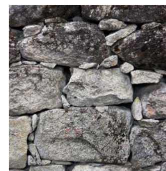
Muro de granito, Porto. Fonte: autor.
