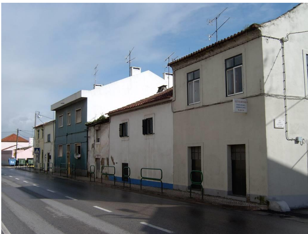
Figura 16: Via principal da Ponte de Frielas (Fonte: Arquivo CML, março 2017).
