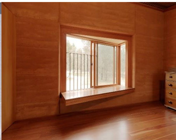
Figura 14 - Parede de taipa em habitação moderna. (Fonte: http://www.steffenwelsch.com.au/residential/rammed-earth-house.html - 13/05/2016)
