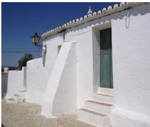
Figura 13 - Contraforte em casa de taipa no Algarve. Cacela Velha. (Fonte: https://ciipcacela.wordpress.com/pessoas-objectos-lugares-e-paisagens/ - 13/05/2016)
