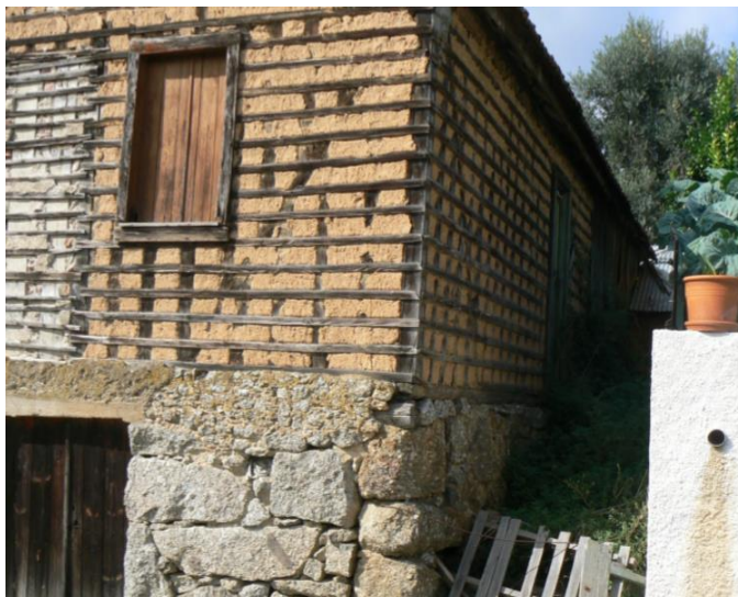
Figura 10 - Habitação antiga com parede exterior em pedra no piso inferior, seguida de parede em tabique no andar superior. (Fonte: http://fringosa.blogspot.pt/2011/09/portela-santa-comba-dao.html - 01/05/2016)
