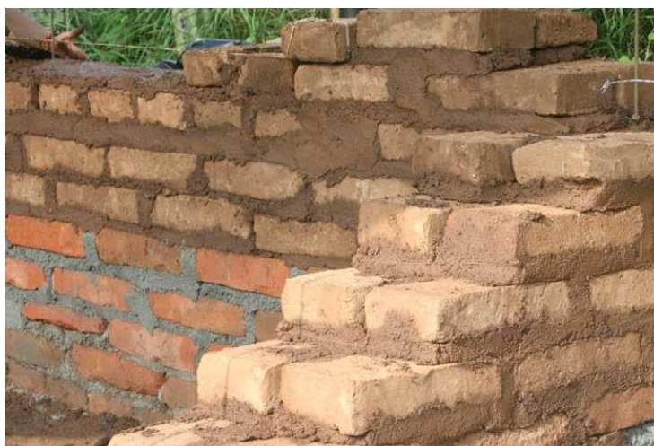
Figura 16 - Construção de paredes em adobe, sobre uma fundação em tijolo cerâmico. (Fonte: http://intermundos.org/residencias/prueba/ - 16/03/2017)
