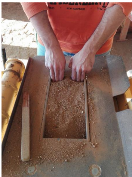
Figura 57 – Pressão sobre os cantos do molde. (Fonte: a autora)
