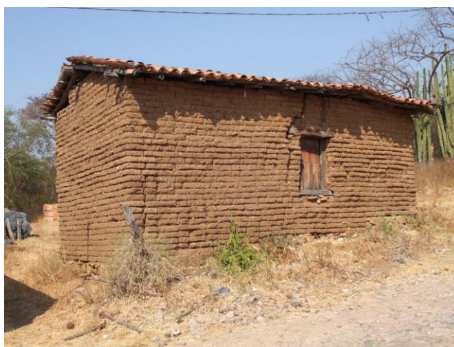
Figura 17 - Habitação rural com paredes em adobe. (Fonte: http://www.panoramio.com/photo/49317623 - 13/05/2016)
