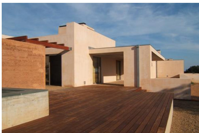
Figura 1 - Habitação unifamiliar construída em taipa. Beja. (Fonte: http://www.betaotaipa.pt/obras_detail.php?obra=habitacao_em_beja - 29/05/2016)
