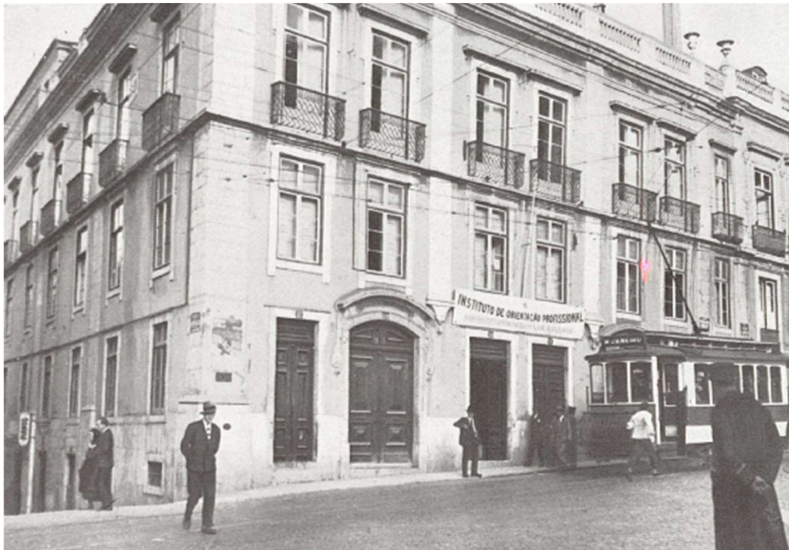
Figura 5.8 – Instituto de Orientação Profissional (fachada)
