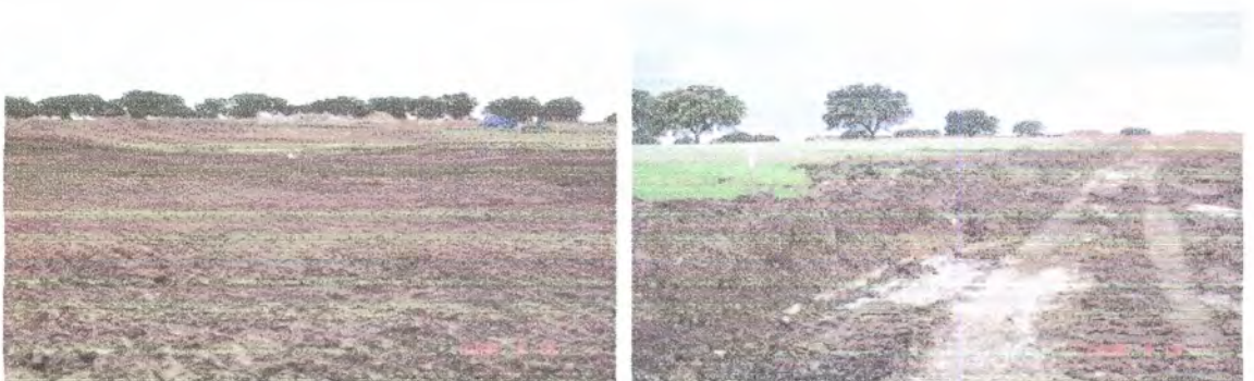
Figura 6.3 - Aspecto geral da fundação da barragem após saneamento.
