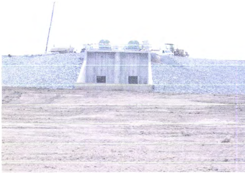
Figura 3.5 – Tomada de Água (Vista de Montante)
