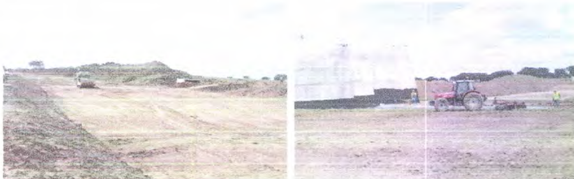
Figura 6.4 - Compactação da fundação e escarificação da camada para permitir ligação com as camadas de aterro
