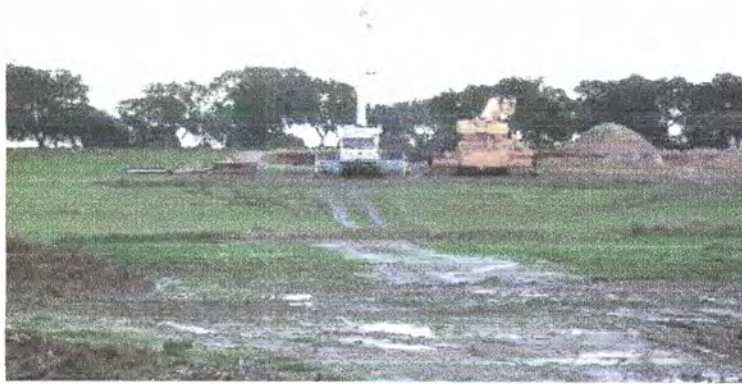
Figura 6.2 - Aspecto geral da zona da barragem, antes do início da decapagem.
