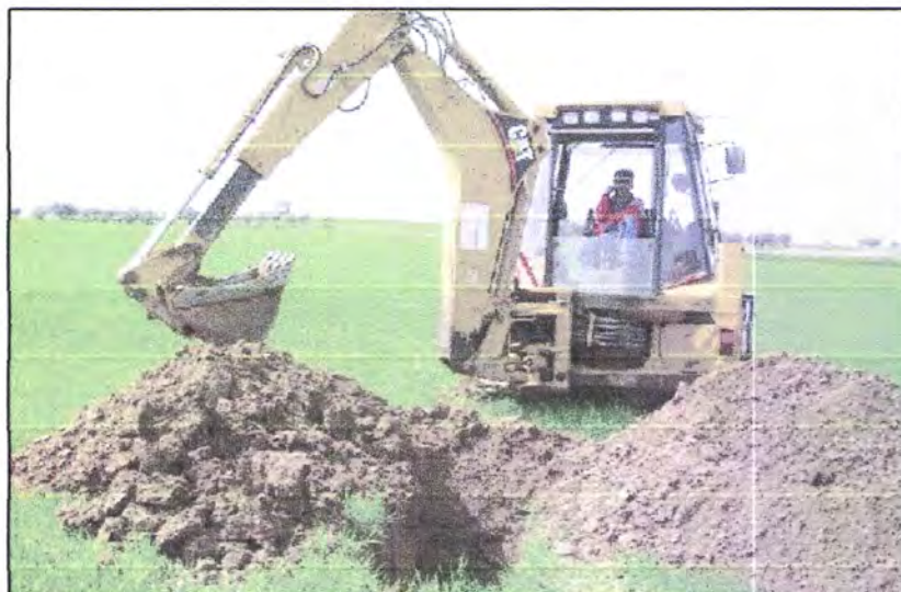
Figura 2.3 - Aspecto geral do material escavado pelos poços. (figura retirada do projecto)
