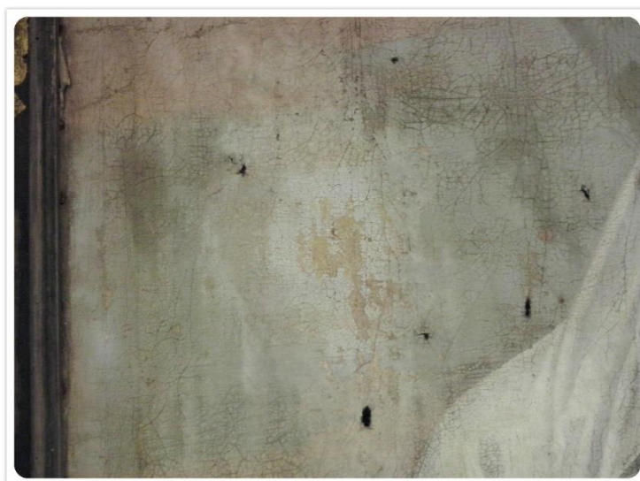
Figura 121 - Danos e Patologias: Lacunas ao nível do suporte. Autor da fotografia: Débora Fortunato.
