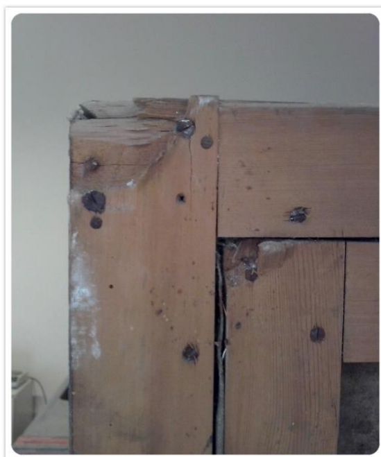
Figura 130 – Danos e Patologias: Perda de material, oxidação de elementos metálicos, presença de fungos. Autor da fotografia: Débora Fortunato.
