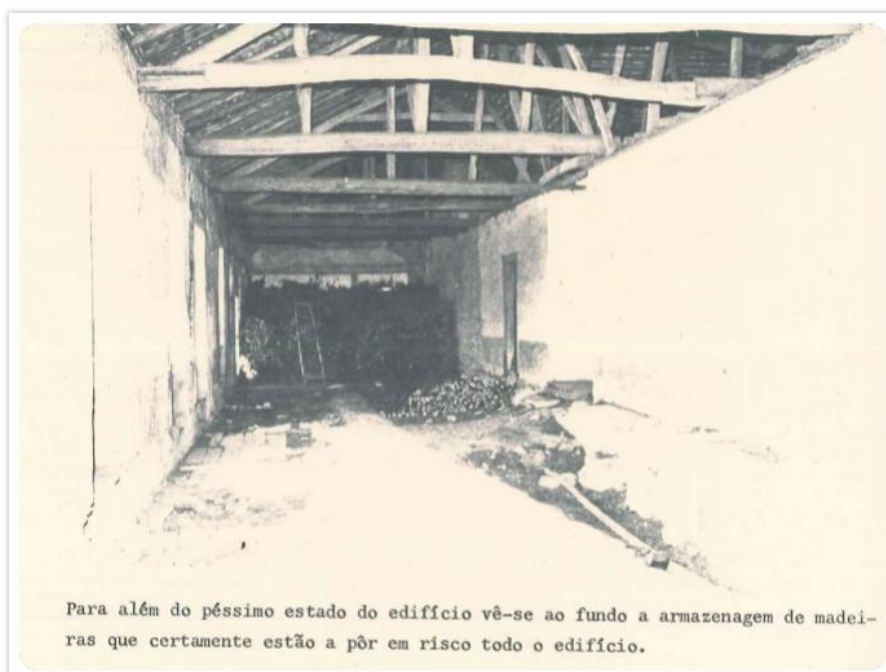
Figura 80 - Interior do Convento de Nossa Senhora dos Remédios. Fonte: Processo de obras do mesmo, localizado na © DORU/CME.
