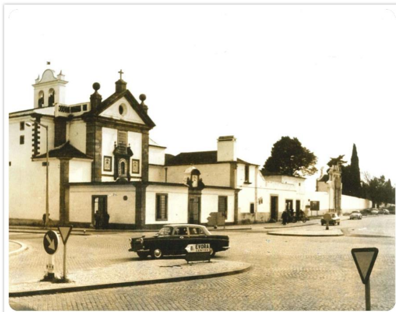
Figura 78 - Convento de Nossa Senhora dos Remédios. Fonte: processo de obras do mesmo, localizado na © DORU/CME.
