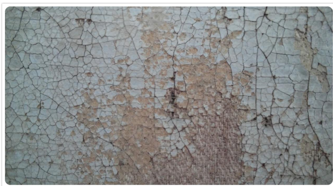
Figura 126 - Danos e Patologias: Destacamento da camada cromática - observação do tom acastanhado da camada de preparação. Autor da fotografia: Débora Fortunato.
