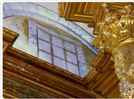
Figura 16 - Pintura a fresco localizada sobre o altar-mor que transparece sobre a cal que parcialmente a cobre. Autor da fotografia: Débora Fortunato.
