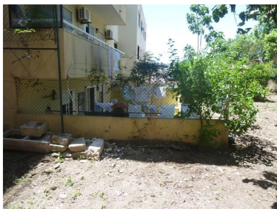
Figura 36 – Fotografia do edifício vizinho sujeito a sujidade (Andreia Duarte)
