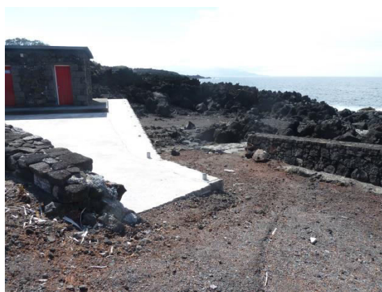
Figura 18 – Fotografia da área de intervenção, “solário” (Luís Cabral)
