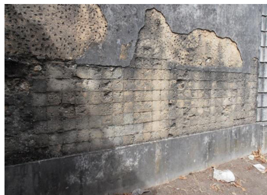
Figura 10 – Fachada do pátio (Arq. Luís Cabral)
