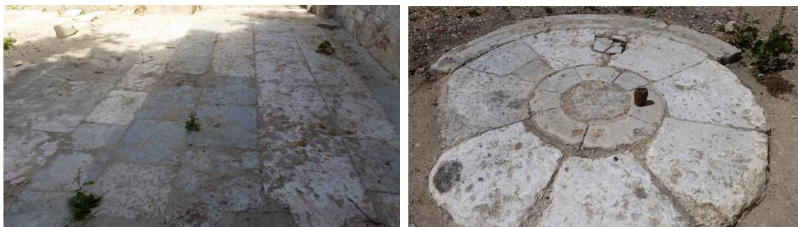
Figuras 7 e 8 – Lajetas de pedra a reaproveitar (Arq. Luís Cabral)
