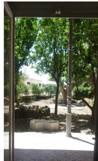
Figura 43 – Fotografia tirada do interior da vivenda no 1º piso, com vista para o jardim. Pilar tipo. (Andreia Duarte)
