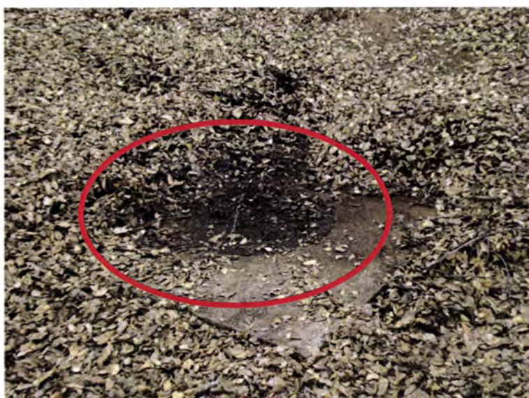
Figura n.ºA.7 – Aspecto exterior da captação FI de Besteiros.
