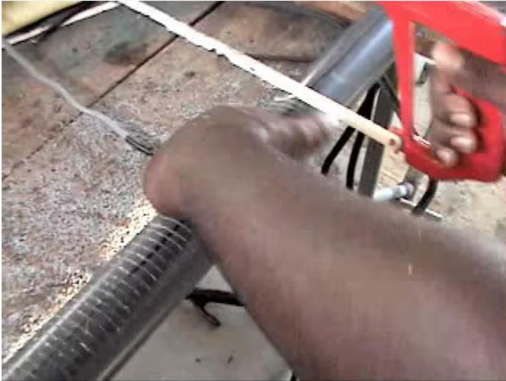
Figura 59: Execução do corte das ranhuras previamente assinaladas (Buchner, 2010b)
