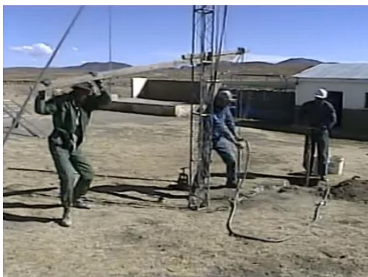
Figura 41: Sondagem EMAS com uso do princípio da alavanca (Buchner, 2010c)
