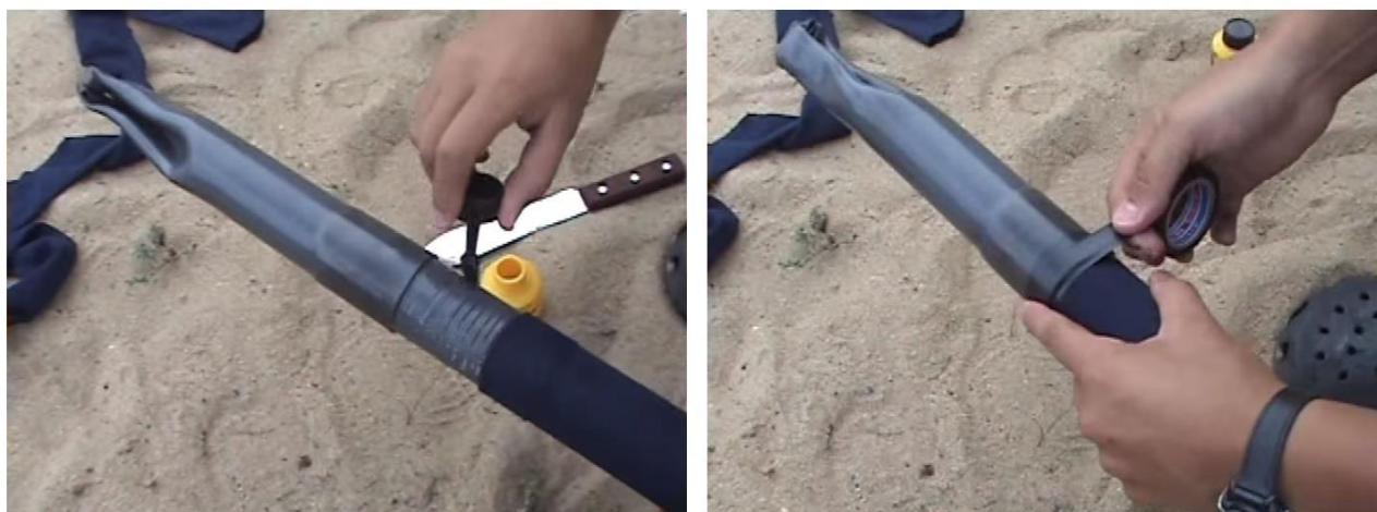
Figura 67: Aplicação de cola e isolamento do fim da manga de nylon (Buchner, 2010b)
