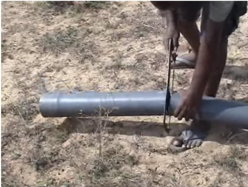
Figura 54: Corte de seção de PVC in situ (Buchner, 2010a)
