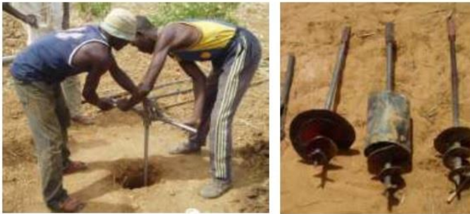
Figura 24: Funcionamento do Auger ligeiro e de tipos de trado (Danert, 2009)
