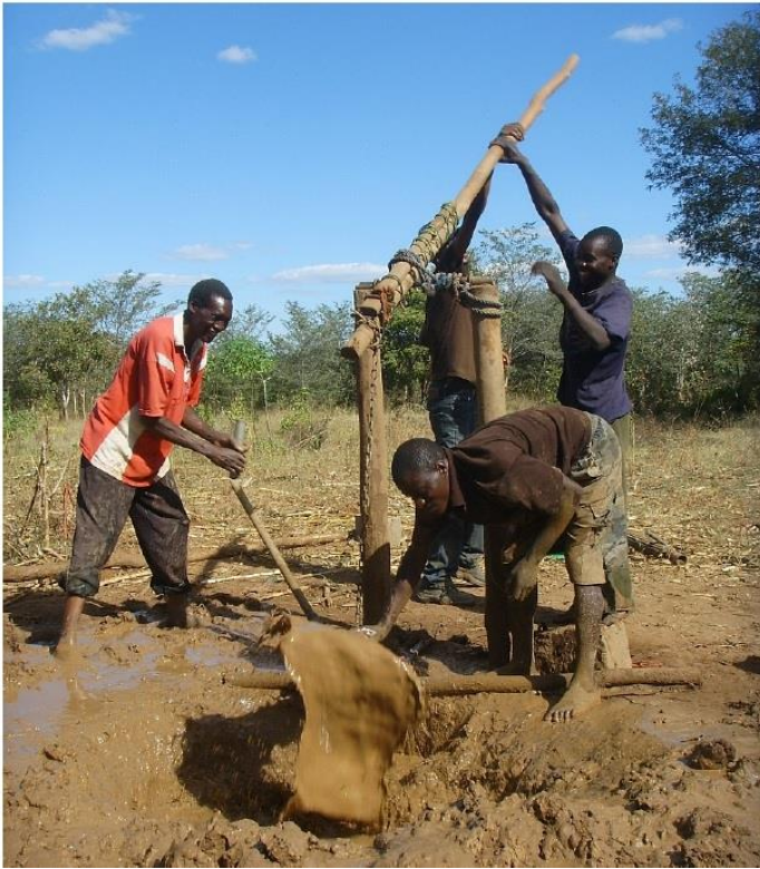
Figura 34: Sondagem Método Rota Sludge (Practica, 2014)
