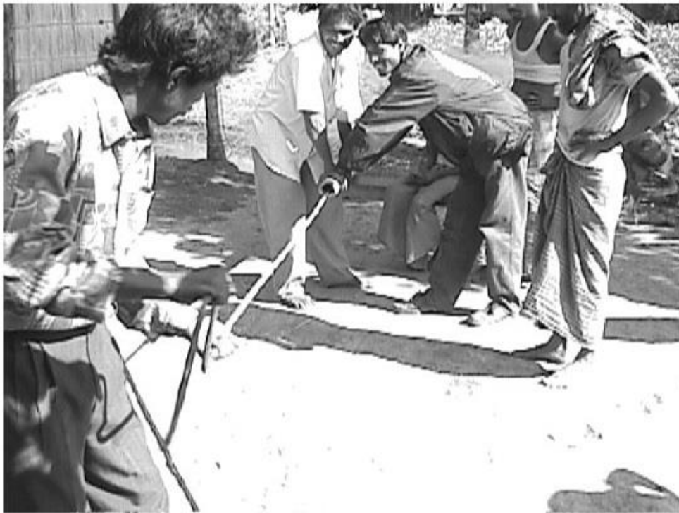
Figura 53: Limpeza das varas de bambu para que possam ser usadas na construção da captação (Ball e Danert, 1999)
