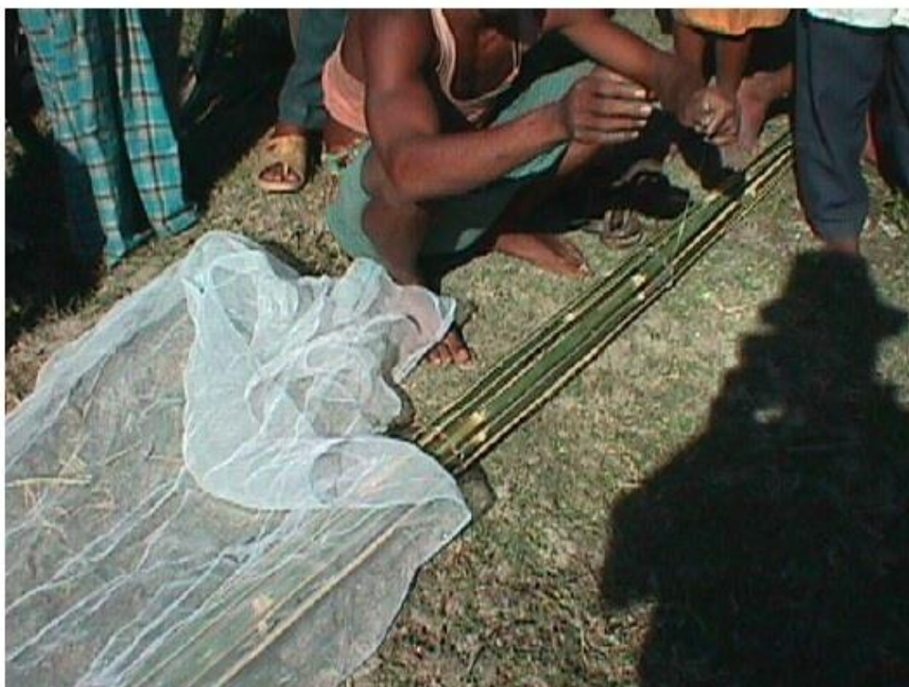
Figura 51: Envolver a tubagem contruída na Figura anterior com rede mosquiteira (Ball e Danert, 1999)
