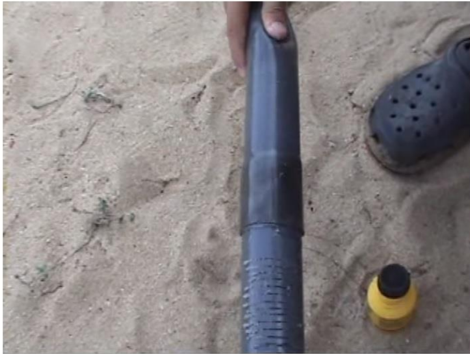
Figura 64: Encaixe final de tampas de base de coluna (Buchner, 2010b)
