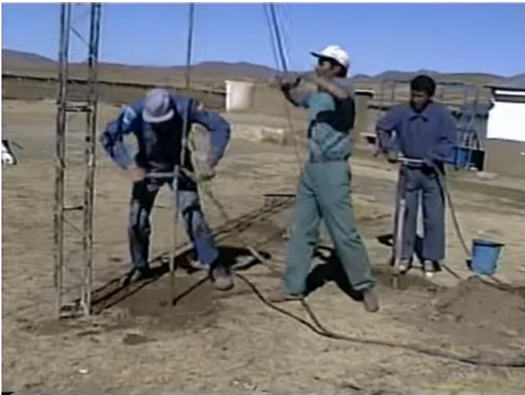
Figura 39: Método de prospecção EMAS com uso de roldana (Buchner, 2010c)
