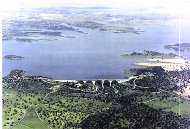
Figura 9 – Vista parcial da albufeira de Odivelas. Adaptado de Matoso [Matoso et al., 2004].
