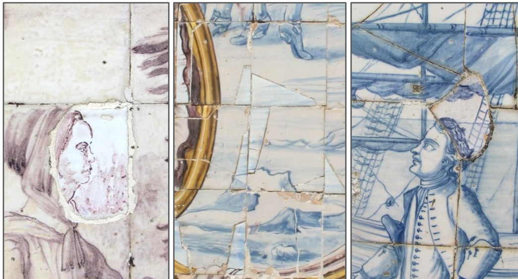
Figura 52. Exemplos de reintegração a quente , recorrendo à manufactura de fragmentos de azulejo vidrado produzidos para preencher a lacuna volumétrica e cromaticamente.
