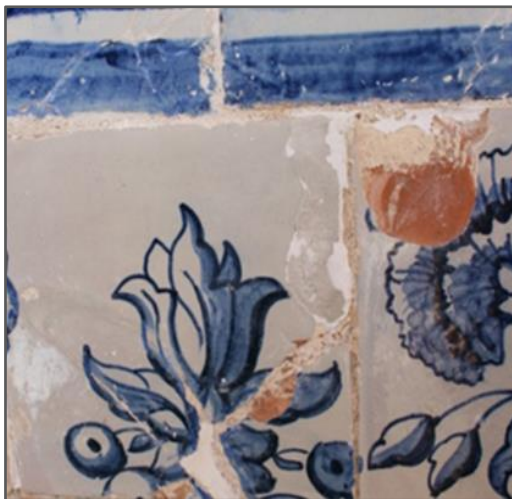
Figura 60. Material de preenchimento de lacunas e de reintegração cromática em destacamento. Claustro inferior da Igreja e Convento de Santa Marta/ Hospital de Santa Marta, 2012.
