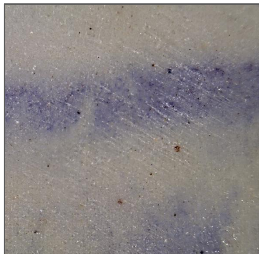
Figura 84. Pormenor dos riscos devidos ao nivelamento das pastas de preenchimento. Palácio Nacional de Queluz. Canal dos Azulejos, 2014.
