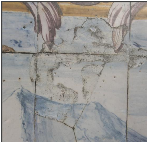
Figura 76. Preenchimentos de lacuna em razoável estado de conservação mas com presença de microorganismos na zona de união entre o material de preenchimento e o vidro original. Palácio Marquês de Pombal, 2012.
