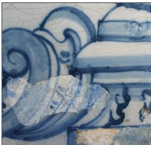
Figura 63. Alteração cromática da reintegração e destacamento do material de preenchimento de lacunas. Claustro inferior Igreja e Convento de Santa Marta/ Hospital de Santa Marta, 2012.
