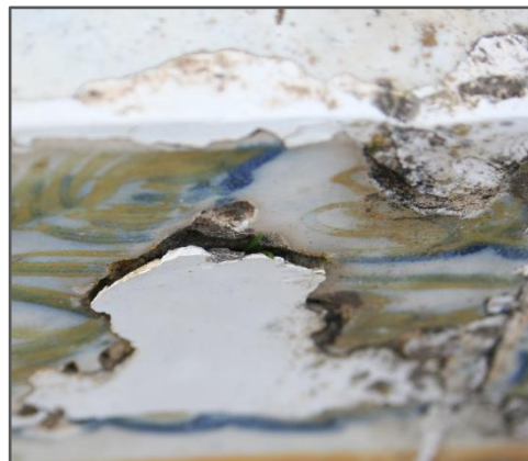
Figura 69. Pormenor de destacamentos devidos à deformação do material de preenchimento. Canal de Queluz, 2012.
