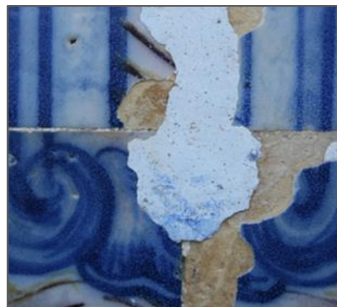
Figura 69. Pormenor de destacamentos devidos à deformação do material de preenchimento. Canal de Queluz, 2012.
