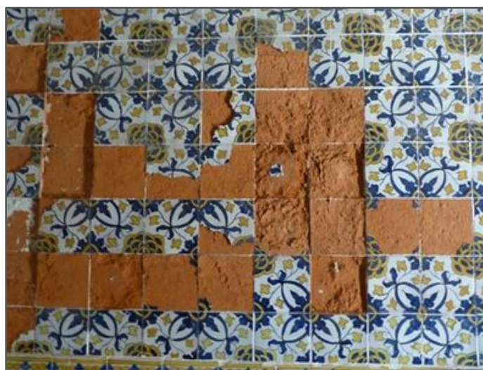
Figura 17. Exemplo de réplicas degradadas junto a azulejos originais. Convento de Chelas. (Foto Sílvia Pereira)
