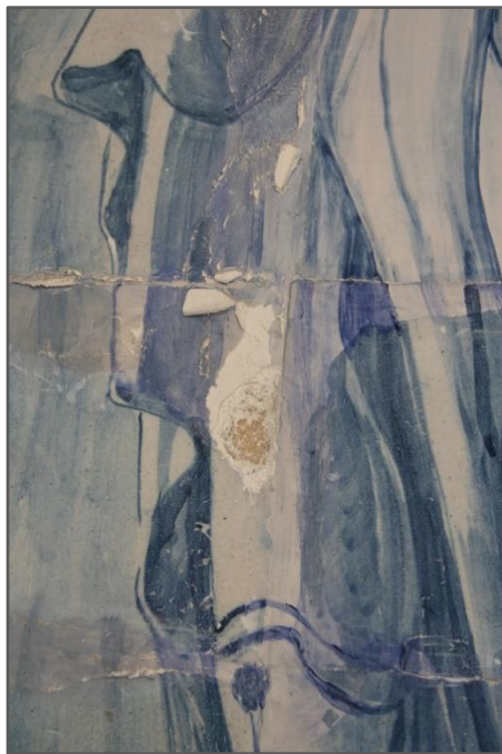
Figura 91. Desagregação e pulverulência das pasta de preenchimento e destacamento da camada de reintegração cromática da pasta de preenchimento. Capelas dos Passos de Elvas, 2013.
