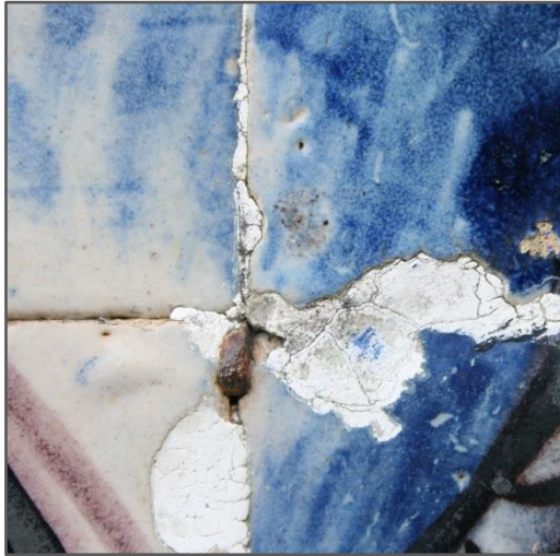
Figura 89. Pasta de preenchimento fissurada e fraturada. Palácio Marqueses de Fronteira, 2014.
