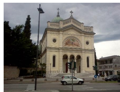
Photo 8 : Église de la ville. (2014). Source : Auteur.
