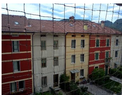
Photo 7 : Maisons pour les ouvriers. (2014). Source : Auteur.
