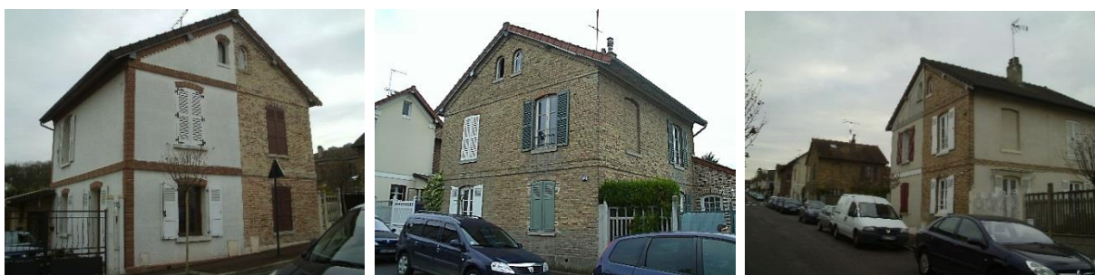
Photo 14, 15 et 16 : Différentes maisons à deux logements dans la cité ouvrière. (2013). Source : Auteur.
