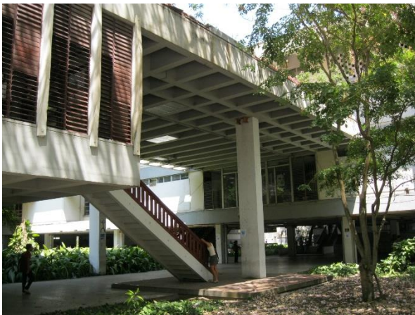
Photo 51 : Présence de galeries qui connectent les bâtiments et qui vont donner de l'ombre dans le parcours piétonnier. Également il y a la présence de fenêtres de persiennes en bois dans les façades sud. L'escalier est aussi un élément de design de l'ensemble. (2012). Source : Auteur.
