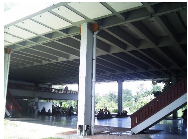
Photo 52 : Présence de grandes hauteurs et éléments structurels du système Lift-Slab visibles. Prévalence de lignes horizontales, en soulignant les planchers en béton armé avec le couleur gris. Les plafonds à caissons sont également visibles et font partie du complexe architectural. (2012). Source : Auteur.
