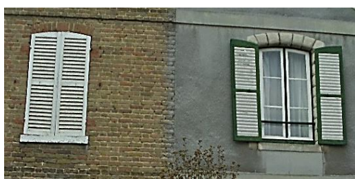
Photo 19 : Ouvertures avec deux types de fenêtres à deux feuilles. (2013). Source : Auteur.
