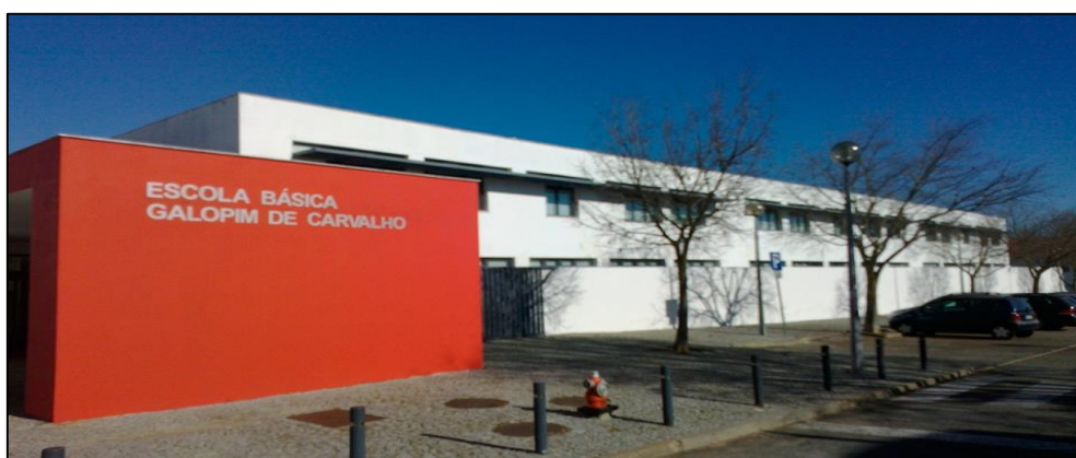
Figura 8: A fachada da instituição
