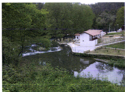
Fig. 10 - Núcleo da Ponte da Igreja
