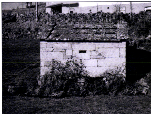
Fig. 3 – Moinho do Morgado – paredes aparelhadas e cobertura de lajes 42
