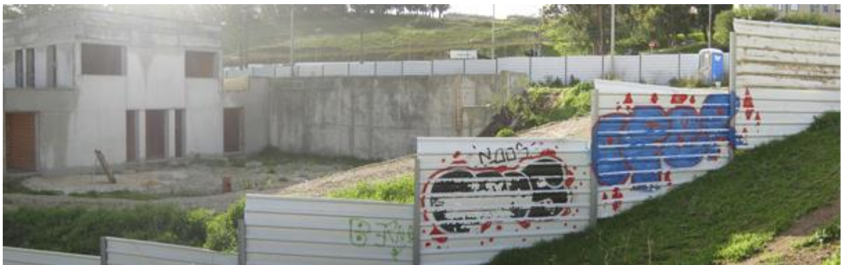
Fig. 26 – Fotografia assinalada a azul – Centro Comunitário em fase de construção, é visível a inclinação do terreno
