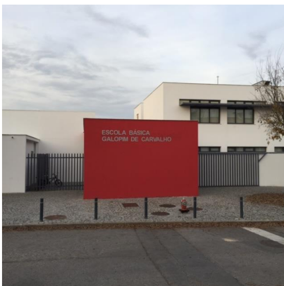
Fotografia 10: Fachada da Instituição
