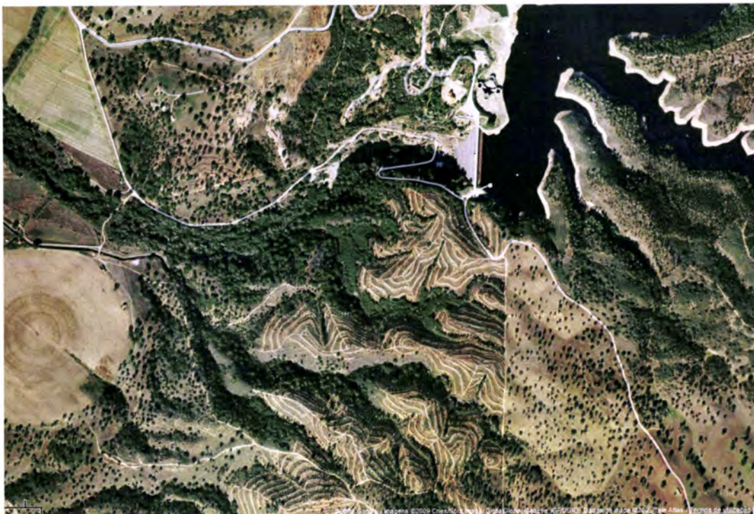
Figura 9: Barragem de Pedrógão
