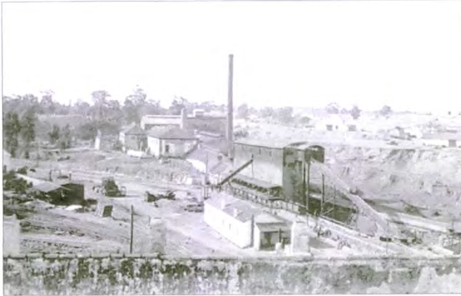
Figura 5. 1 - Cais e Central Termoelétrica da Mina de São Domingos
