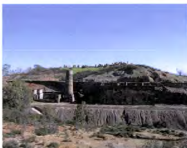
Figura 5. 2 - Moitinha, Estação de britagem
