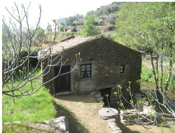
Fig. 29 – Azenha da Figueira. Edifício restaurado com azenha em funcionamento.
