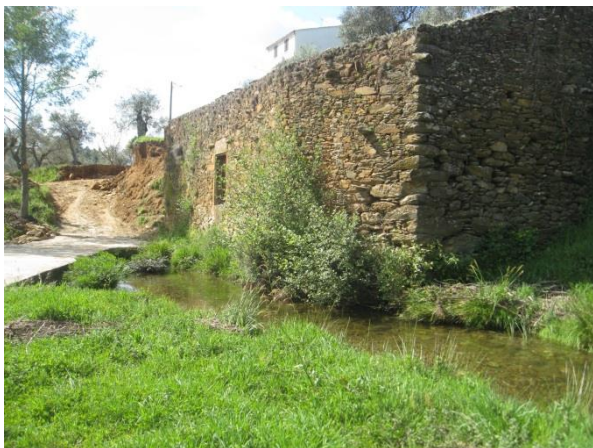
Fig. 28 – Azenha em ruínas junto ao açude. Elemento futuramente reabilitado como estrutura de apoio ao parque – bar e balneário.
