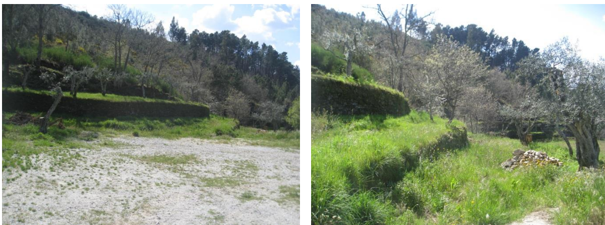
Fig. 33 – Socalcos existentes nos limites do estacionamento
