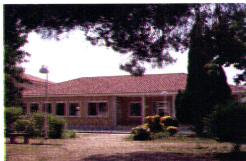
Figura 8 - Edifício do bar e refeitório da ESTGA.
