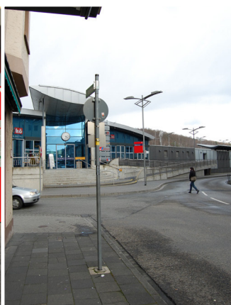
Figura 6 - Entrada estação ferroviária
