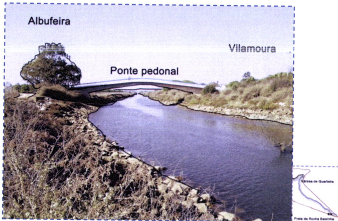
Figura 49 – Margens deprovidas de vegetação arbórea
