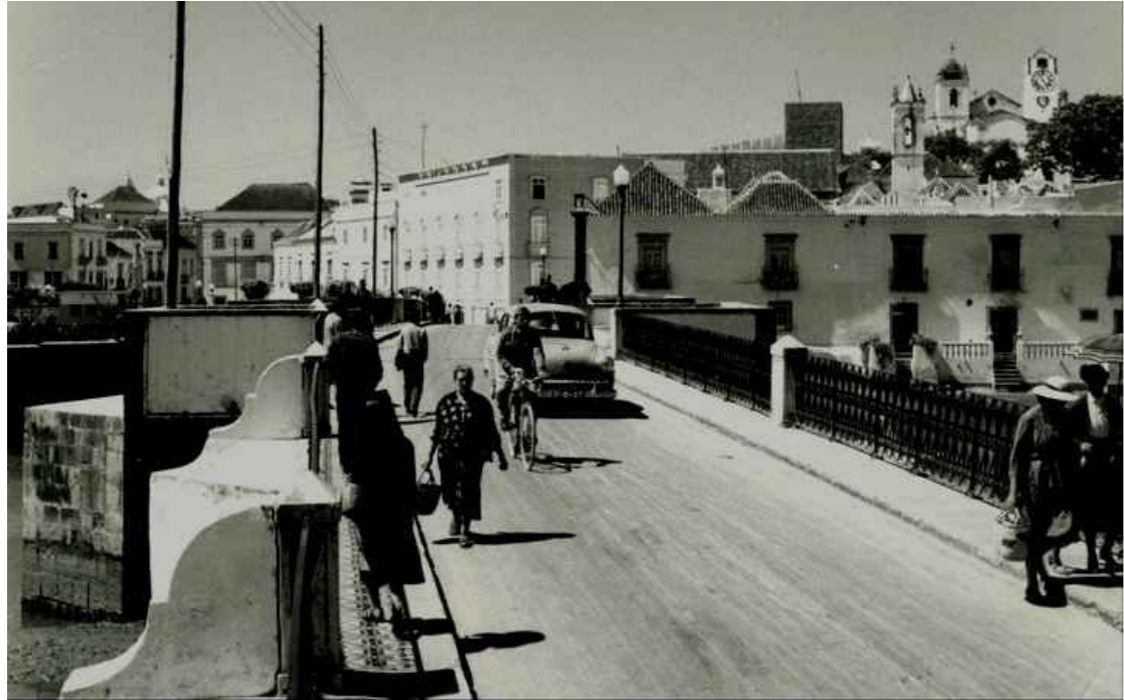
[50] Tráfego na ponte antiga de Tavira.
