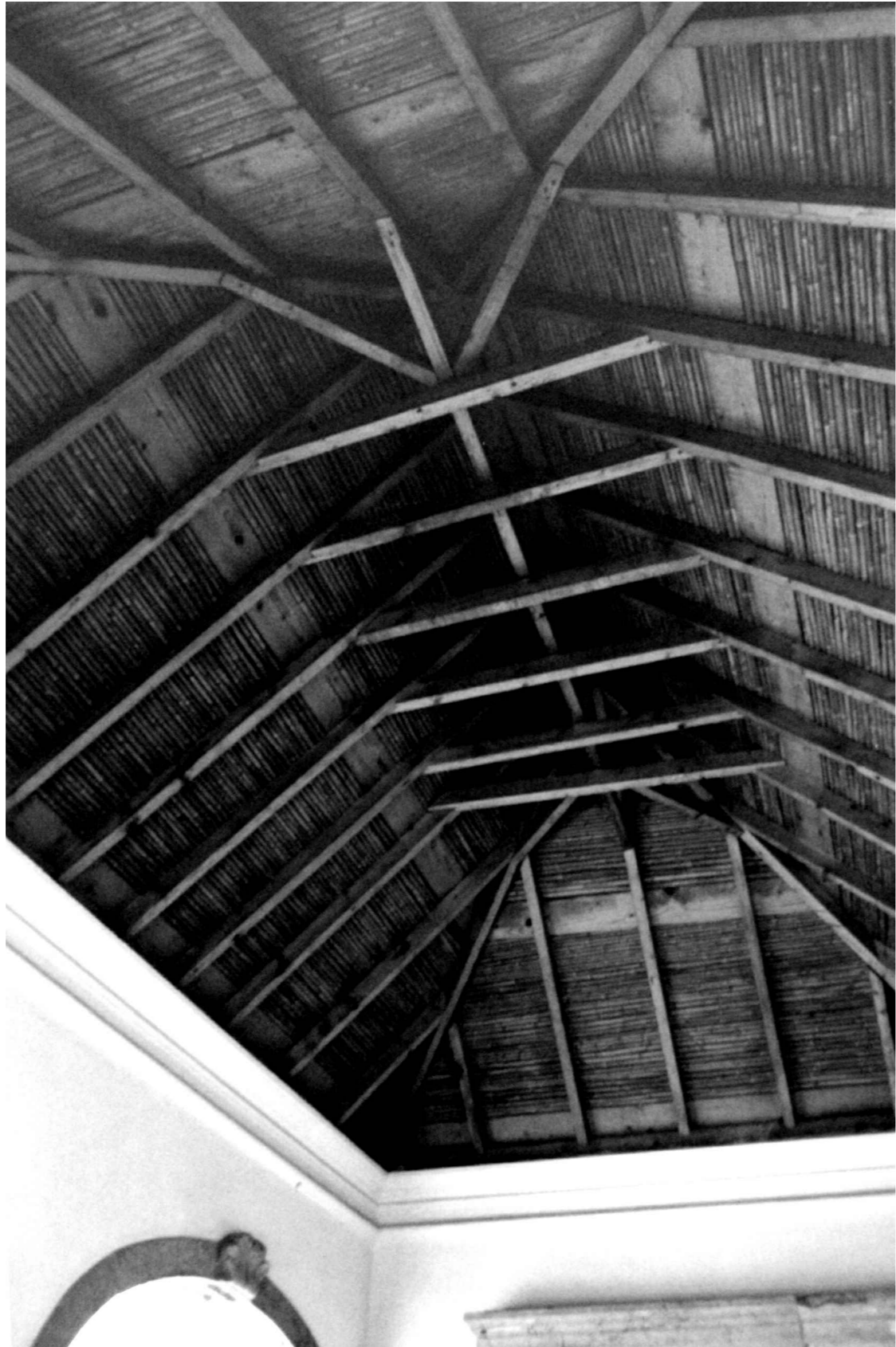
| 17 | Estrutura de madeira de um telhado de tesouro, Palácio da Galeria, Tavira.
