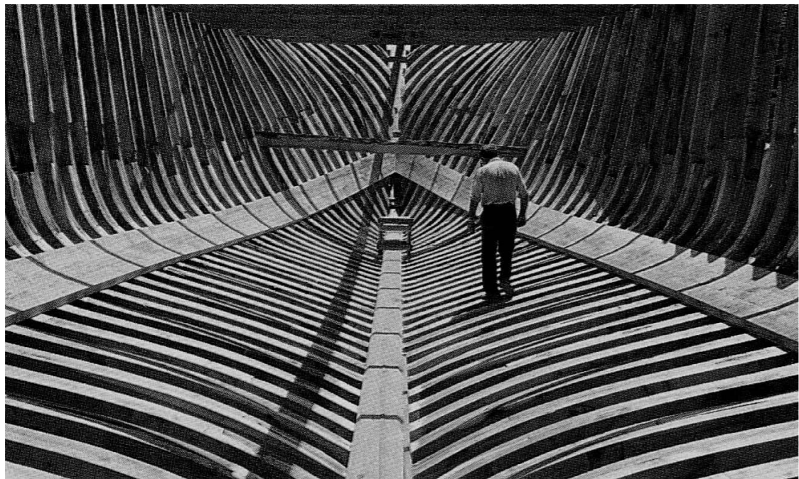
[5] Cavername de barco em construção nos estaleiros de Santo Amaro (Ilha do Pico)
