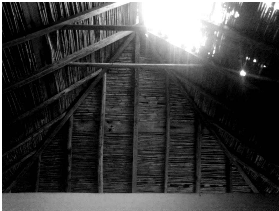
| 16 | Estrutura de telhado de tesouro das casas acima.
