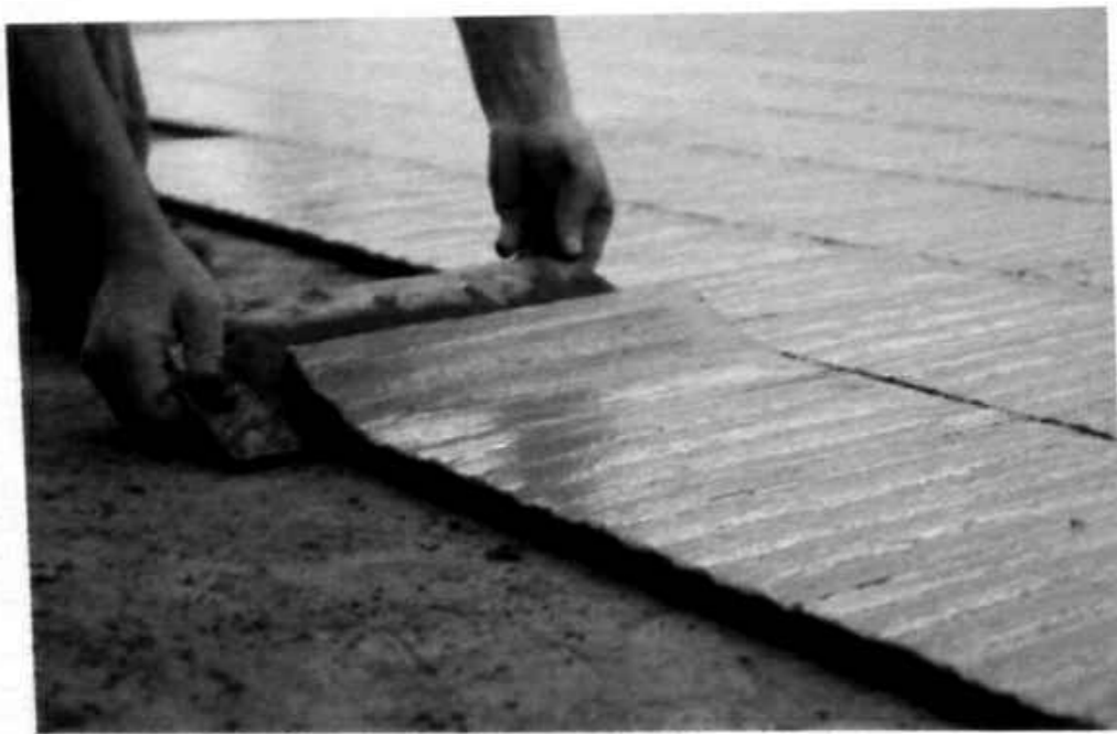
| 19 | A manufatura das telhas.
