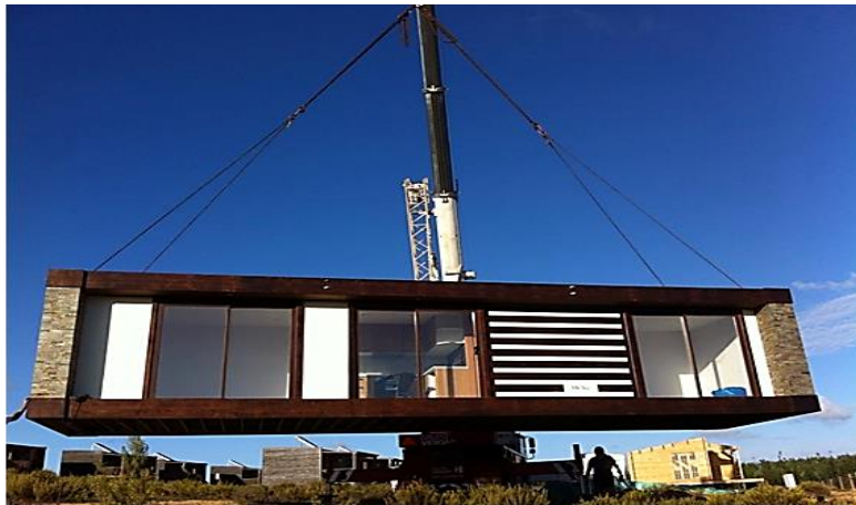
Figura 209 – Colocação do projeto já terminado no local pretendido. (Miguel Jorge)
