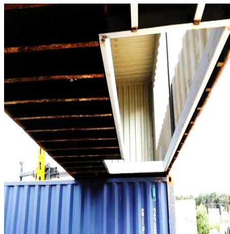
Figura 66 – Exemplo de um corte no piso para colocar escadas. (IKEGAMI, CASTILHO, & KOCHANOWSKI, 2015)
