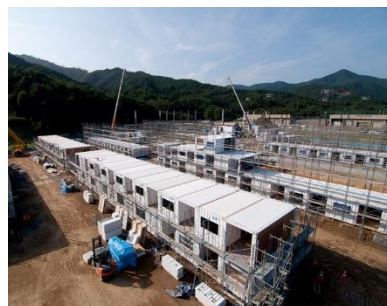
Figura 183 – Colocação dos contentores no projeto Onagawa Container Temporary Housing. (Shigeru Ban architects)
