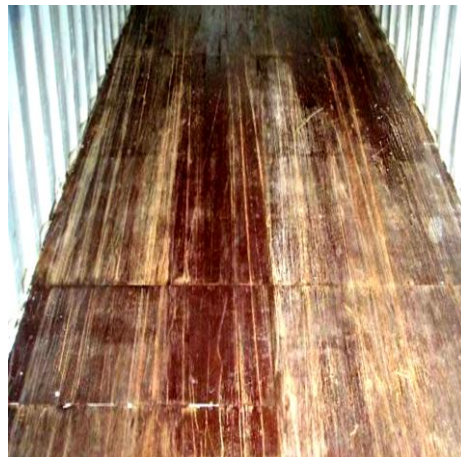
Figura 35 – Desgaste normal do piso, é reparável, pode ser lixado e depois revestido com outro material. (GREENCUBE, 2012)
