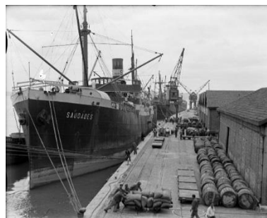
Figura 5 – Descarga do navio "Saudades" no Entreposto Colonial de Lisboa. (Luís Pavão)
