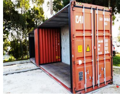
Figura 59 – Exemplo de um corte grande, bem feito, onde é respeitada a estrutura original do contentor. (IKEGAMI, CASTILHO, & KOCHANOWSKI, 2015)
