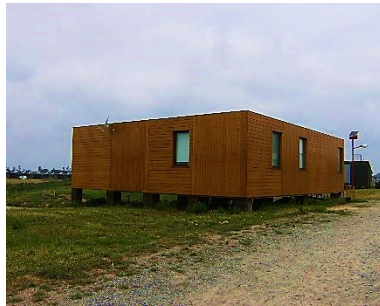
Figura 210 – Zona exterior do Projeto “Zmonte”.
