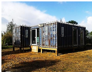
Figura 198 – Preparação do revestimento exterior da casa “Fred 204” – Santarém. (MyModhouse)
