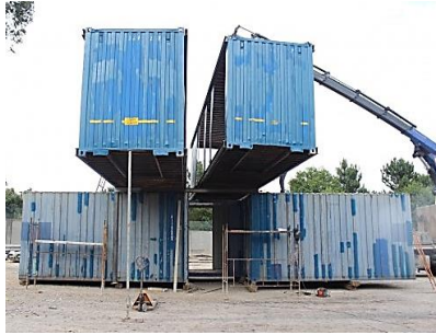
Figura 201 – Colocação dos contentores da casa Pilar Box. (Domux Box)
