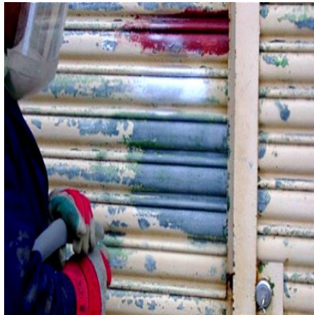
Figura 40 – Limpeza do contentor com jato de areia. (GREENCUBE, 2012)
