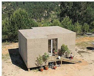
Figura 199 – Fotografia da casa Fred 204, já completa, com o revestimento em cortiça. (MyModhouse)
