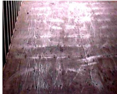
Figura 34 – Nesta imagem pode ver-se o piso ondulado, entre as travessas do contentor, neste caso é claramente importante substituir o piso. (GREENCUBE, 2012)
