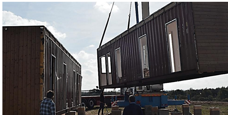
Figura 212 – Colocação dos contentores que foram preparados em fábrica e depois transportados para o local. (JGDS)
