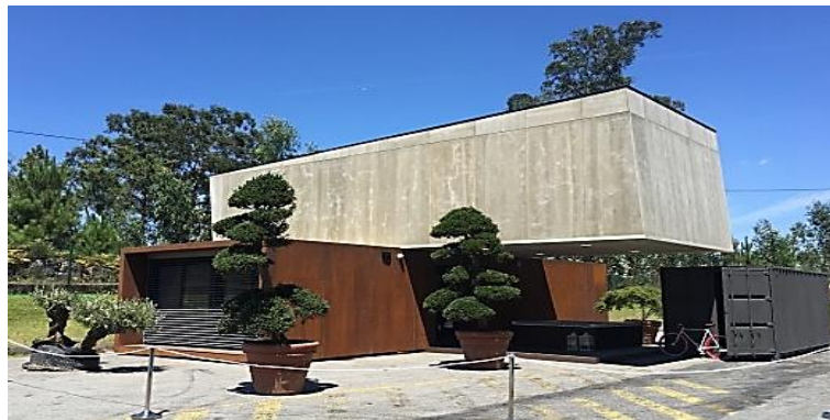
Figura 203 – Casa já terminada. (Domux Box)
