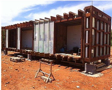
Figura 207 – Preparação do contentor para a colocação do revestimento exterior. (Miguel Jorge)
