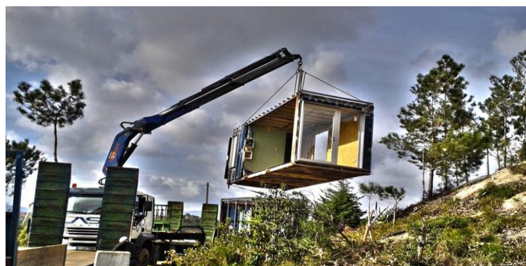
Figura 200- Colocação da casa no local, com o apoio de uma grua. (MyModhouse)
