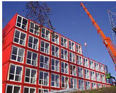
Figura 204 – Projeto: Keetwonen, colocação dos contentores. (SLAWIK, BERGMANN, BUCHMEIER, & TINNEY, 2010)
