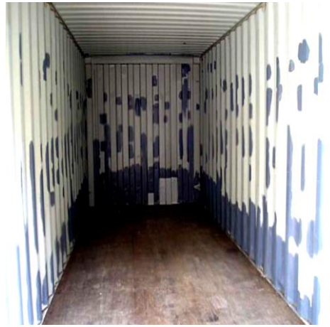
Figura 39 – Interior do contentor já com varias correções e reparos. (GREENCUBE, 2012)
