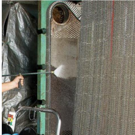
Figura 41 – Limpeza com máquina de pressão. (GREENCUBE, 2012)
