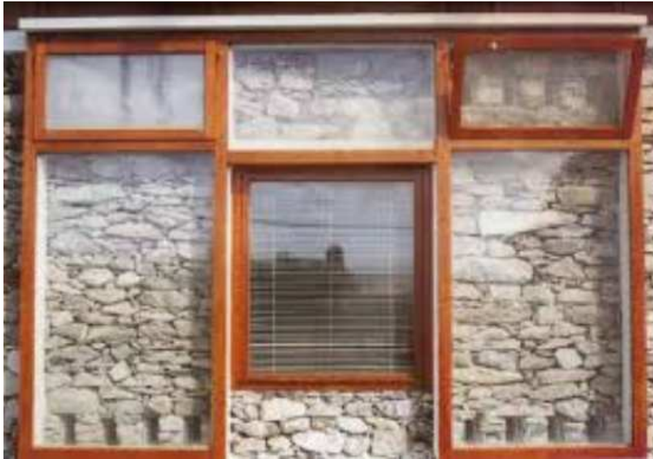
Figura 6. Exemplo de parede de Trombe construída (in[22]).
