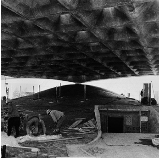
:42 Pavilhão do Brasil da Expo'70, em Osaka, Japão. (1969 - demolido)
