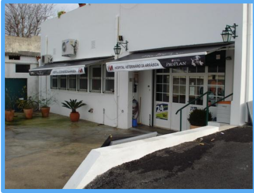
IMAGEM 1: FACHADA PRINCIPAL DO HVA
