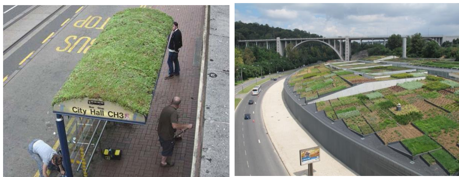
Figura 13 e 14 – Sheffield Bus Shelter, Inglaterra (à esquerda - Fonte: Pereira, A., Contreras, E., P., Palha, P., (2012); ETAR de Alcântara, Lisboa (à direita - Fonte: http://www.adp.pt )
