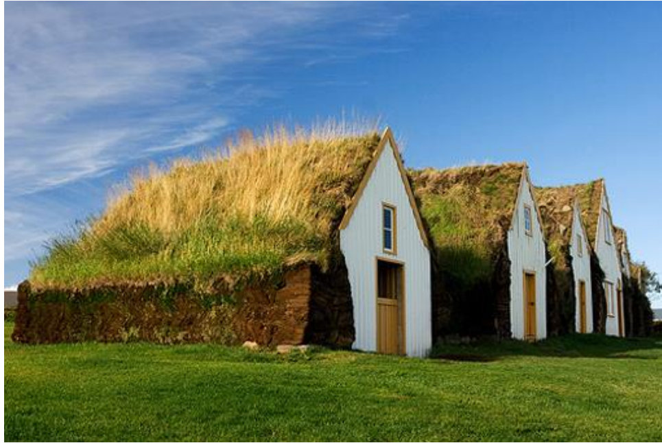
Figura 5 – Edificação tradicional de terra e gramíneas (Haukadalur – Islândia) Fonte: Burgess, (2004)
