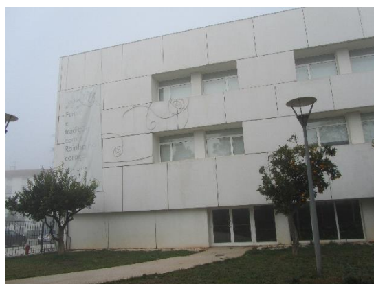
Figura 24 - Pormenor do Edifício
