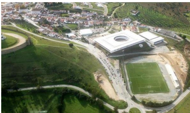
Figura 37 - Vista Aérea do Edifício da EBCR
