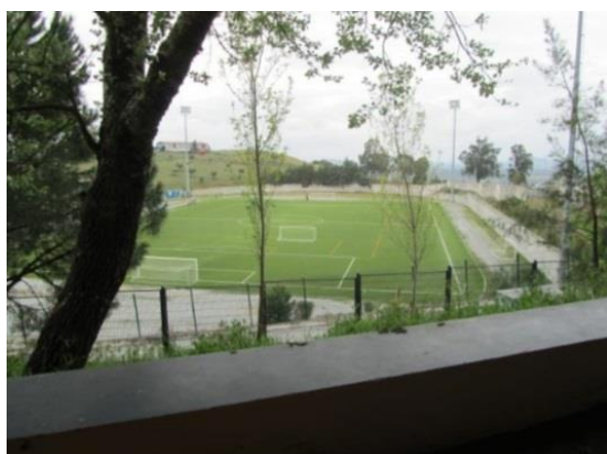
Figura 40 - Exterior do Edifício
