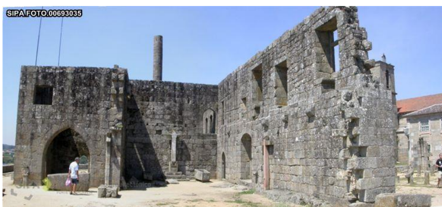
Fig. 81 – Paço dos Condes de Barcelos, fachada este, 2005. IHRU/SIPA, sipa.foto.00693035.
