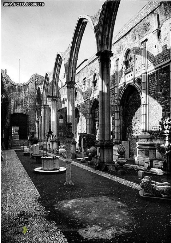
Fig. 62 – Ruínas da Igreja do Convento do Carmo.
